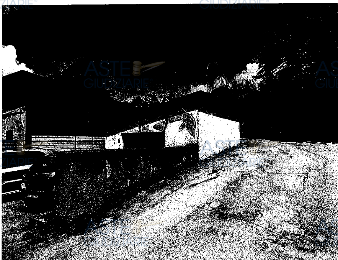
Figura 2 – Panoramica Garage Piano Terra.
