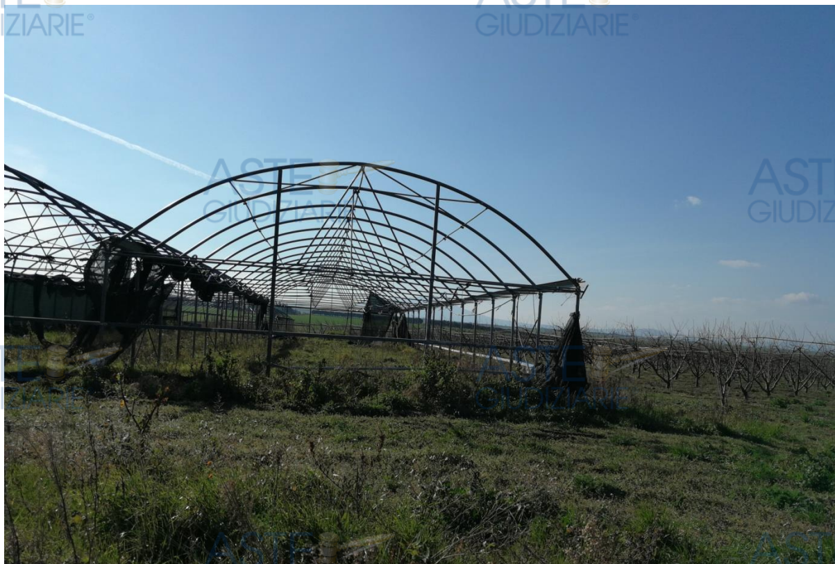
Figura 4 – Panoramica Terreni Foglio 14, p.lla 417.
