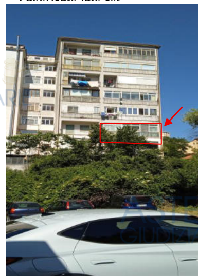
Fabbricato lato est
