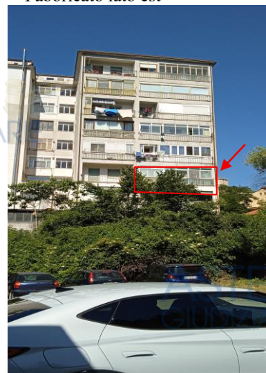
Fabbricato lato est
