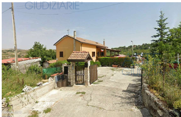
Vista del fabbricato e dell'accesso al piazzale su Via Creta
