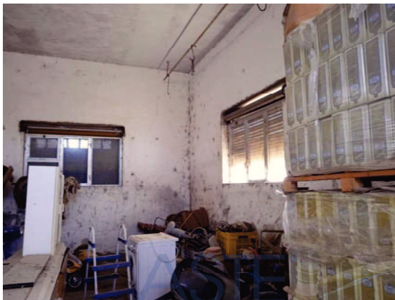
Part. 405 sub 3 - Vista interna deposito
