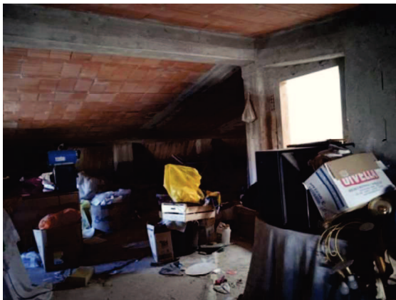
Part. 405 sub 11 - Vista interna piano secondo
