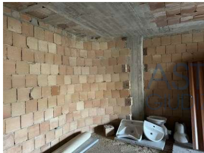
FOTO 44 – Lotto in Corso di Costruzione P. 1.
