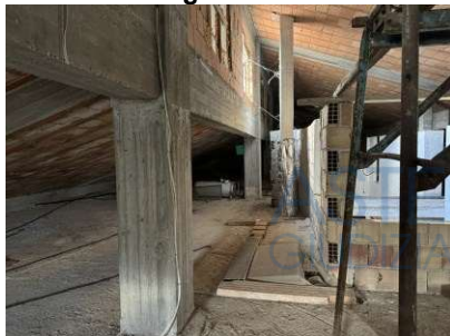
FOTO 57 – Soffitta al P. Sottotetto.
