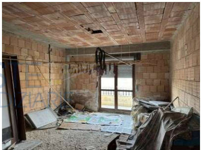
FOTO 43 – Lotto in Corso di Costruzione P. 1.
