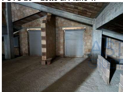
FOTO 29 – Soffitta al Piano Sottotetto.
