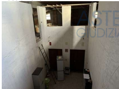
FOTO 48 – Lotto in Corso di Costruzione P. 1.
