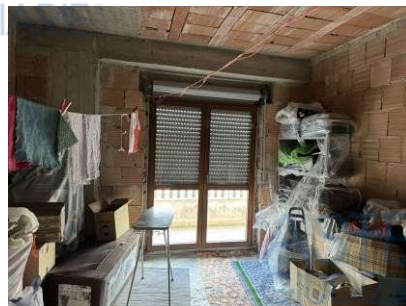
FOTO 42 – Lotto in Corso di Costruzione P. 1.
