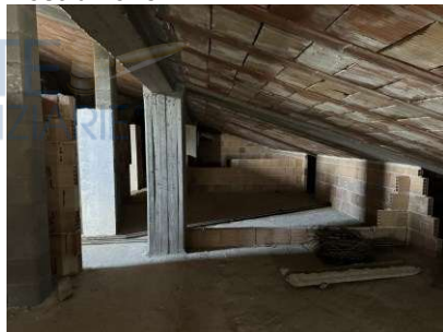
FOTO 47 – Lotto in Corso di Costruzione P. 1.
