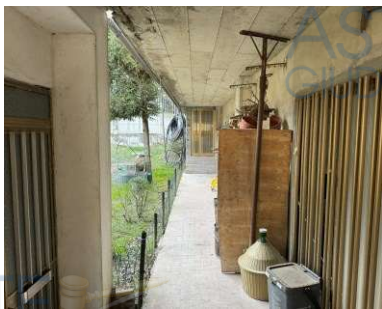
FOTO 8 – Deposito al Piano Ammezzato 2.
