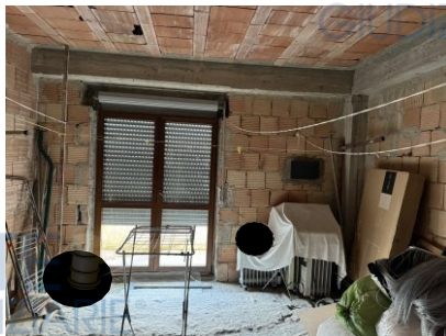
FOTO 41 – Lotto in Corso di Costruzione P. 1.
