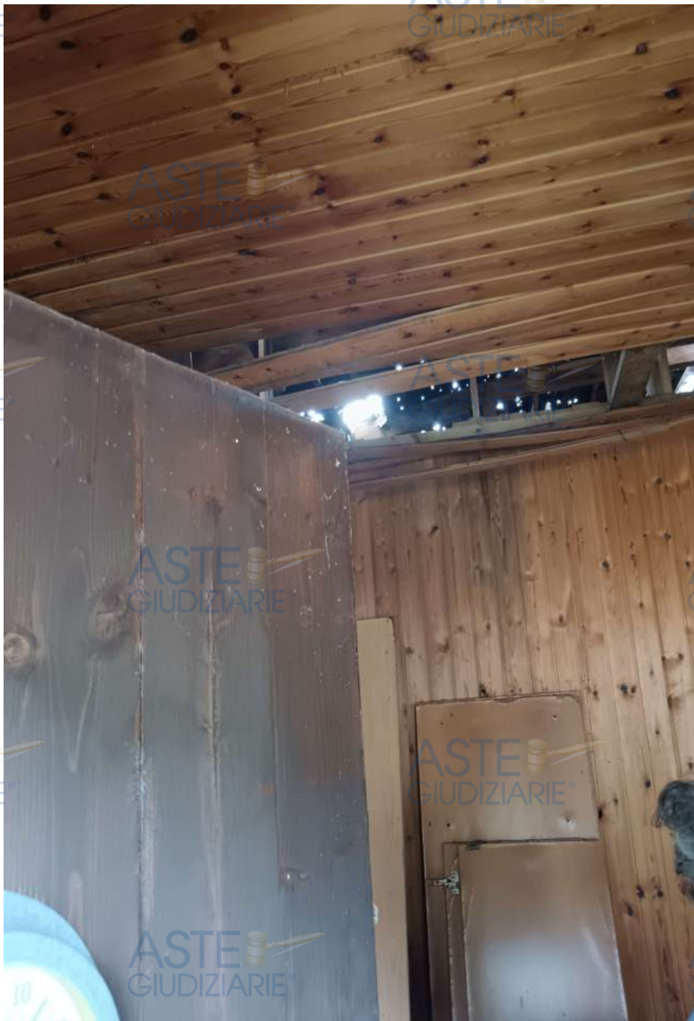
Foto n°12 Particolare del tetto del prefabbricato "D"
