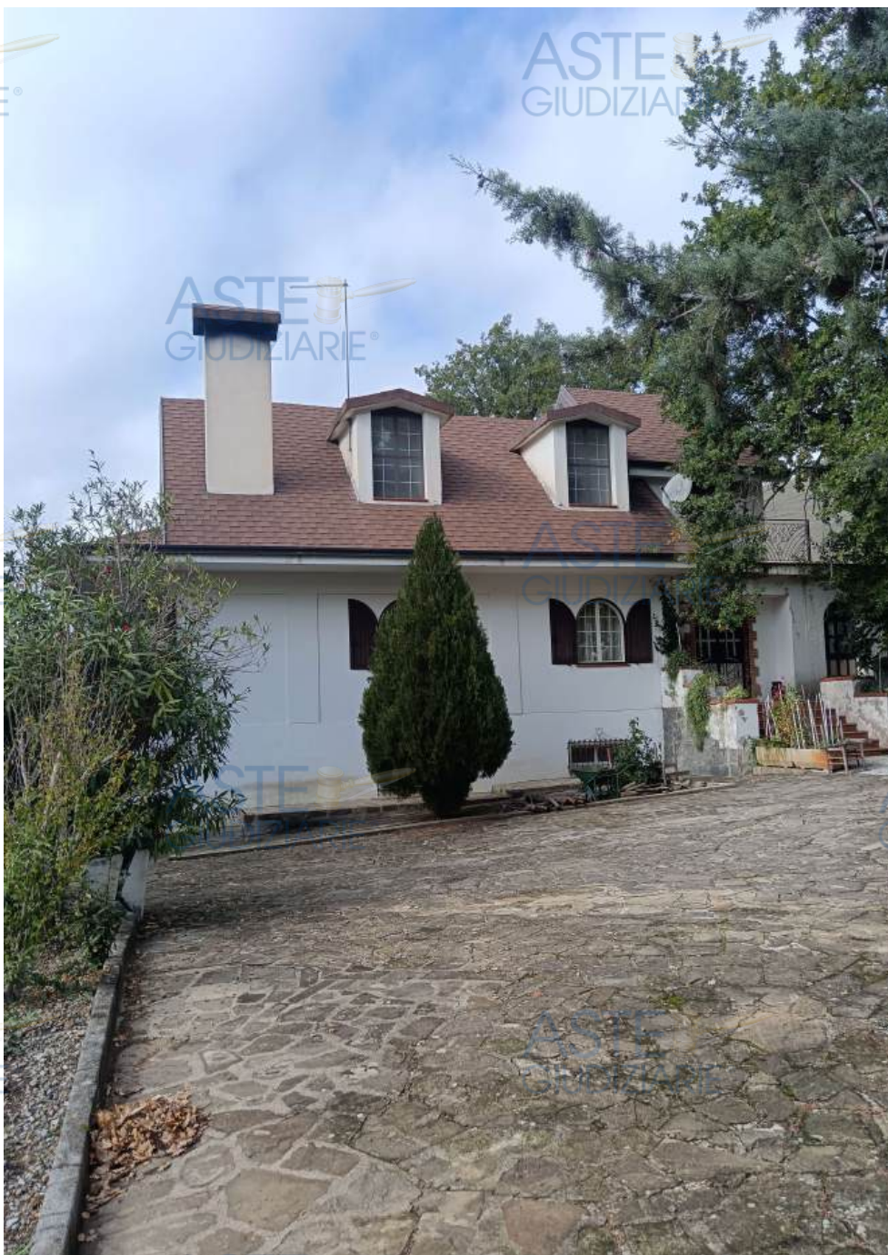
Foto n.1 Fabbricato principale "A"
