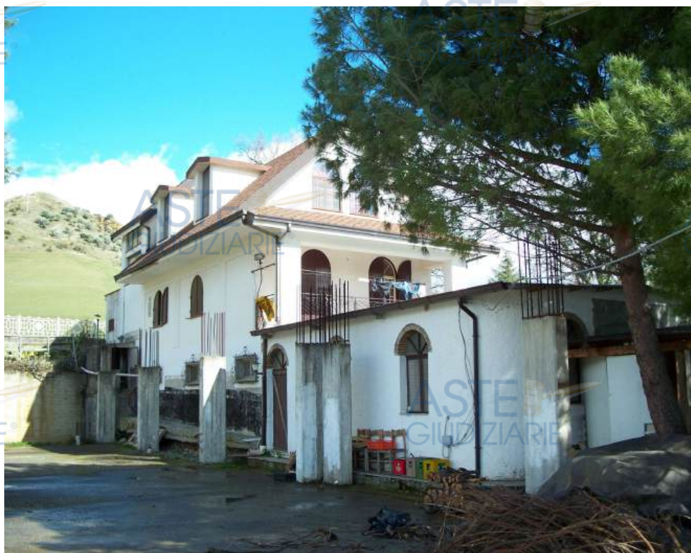
Foto n.5 Fabbricato in corso di costruzione "E"
