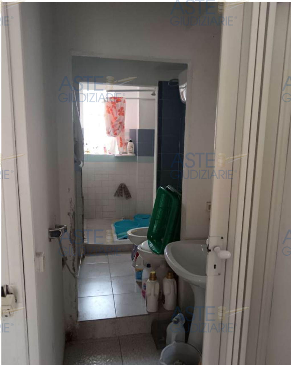
Foto n°9 Particolare del bagno a piano terra
