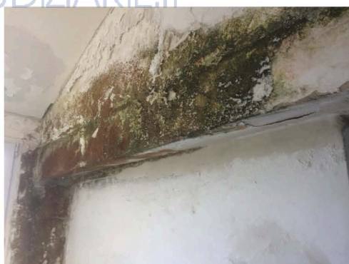
Infiltrazioni dal solaio corpo scala
