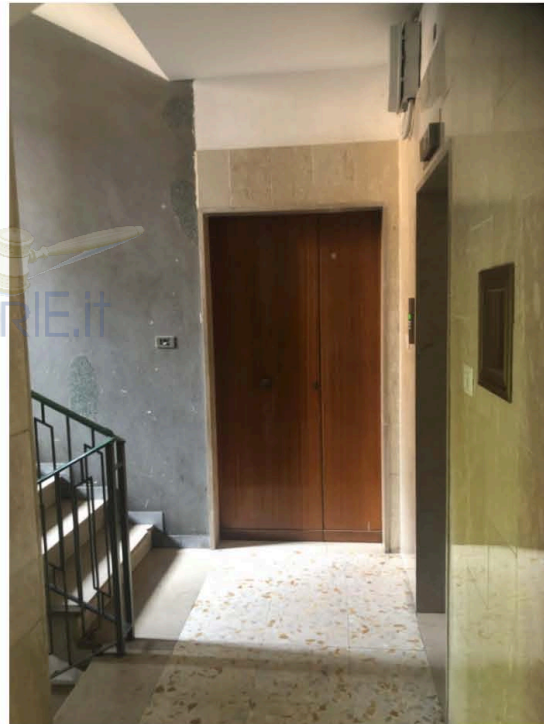
Caposcala di accesso al sub 39 (ex 25)
