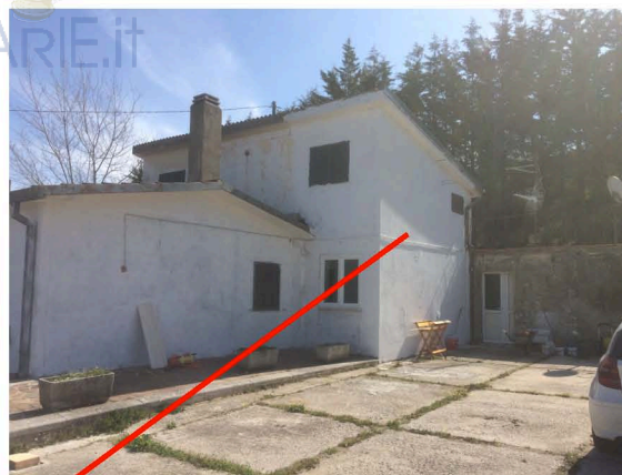
Parte realizzata in muratura
