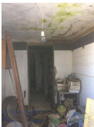
Vista interno cantina
