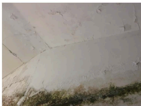
Infiltrazioni dal solaio corpo scala
