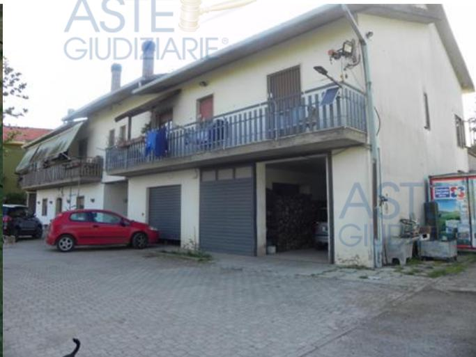
I cespiti consistono di appezzamenti di terreno con entrostante un fabbricato ad uso residenziale con struttura portante in muratura con solai in latero-cementizi e copertura con manto di tegole completa di canali di gronda, discendenti e scossaline.
