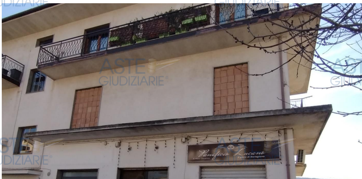
Figura 23. Aperture esterne murate.
