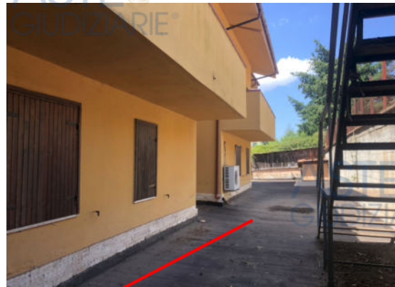
Solaio di copertura dell'interrato
