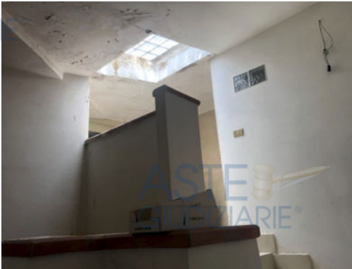
Gradinata di collegamento alla soffitta
