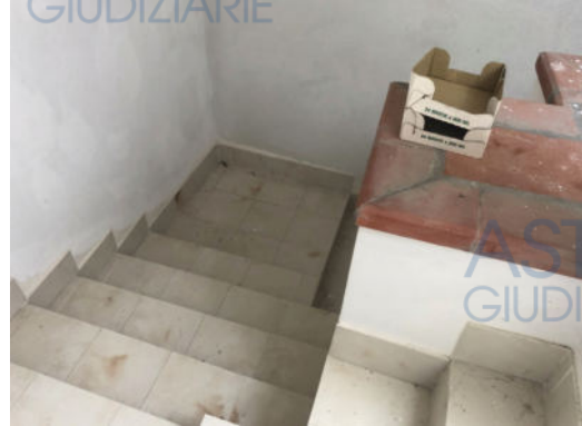
Gradinata di collegamento alla soffitta
