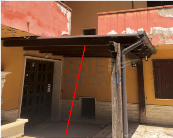
Tettoia A sull'ingresso
