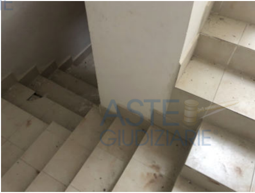
Gradinata di collegamento alla soffitta
