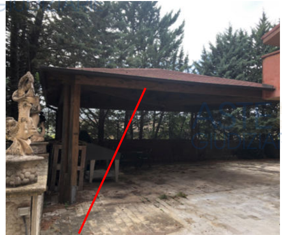
Tettoia B nei pressi dell'ingresso
