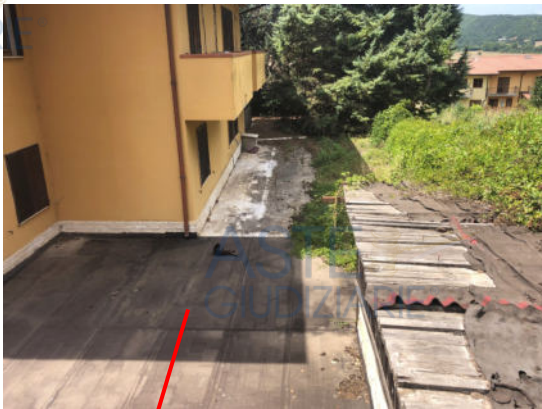
Solaio di copertura dell'interrato
