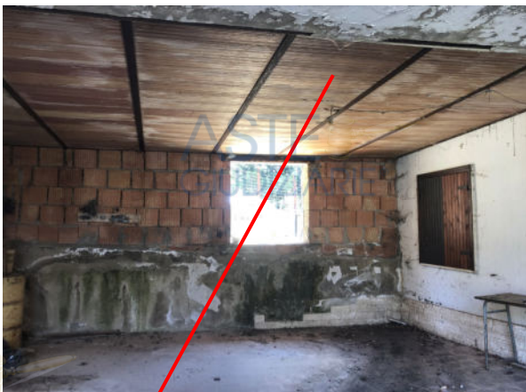
Solaio a fianco alla passerella
