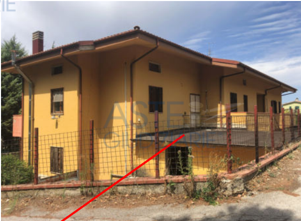
Solaio a fianco alla passerella
