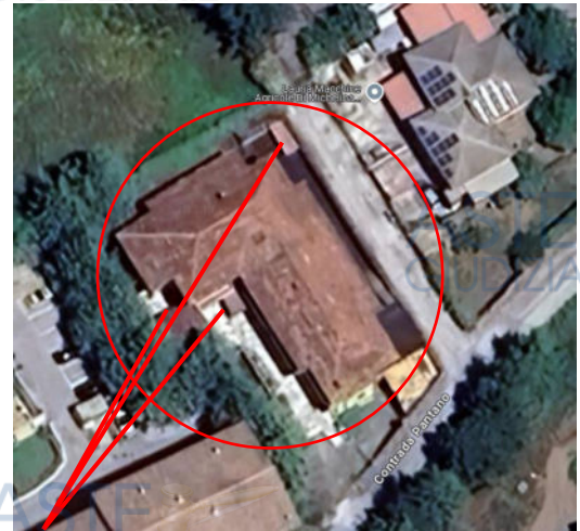
Tettoie e locali abusivi non accatastati
