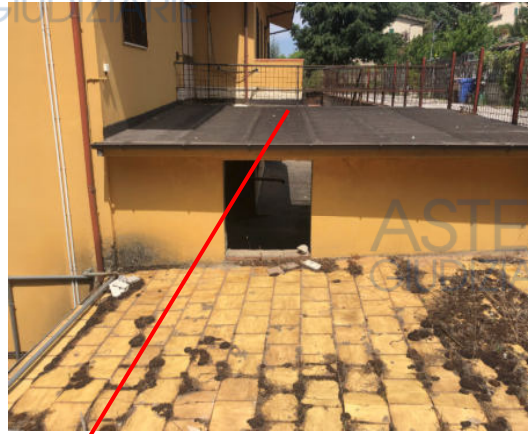
Solaio a fianco alla passerella
