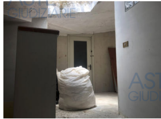
Ballatoio di arrivo alla soffitta
