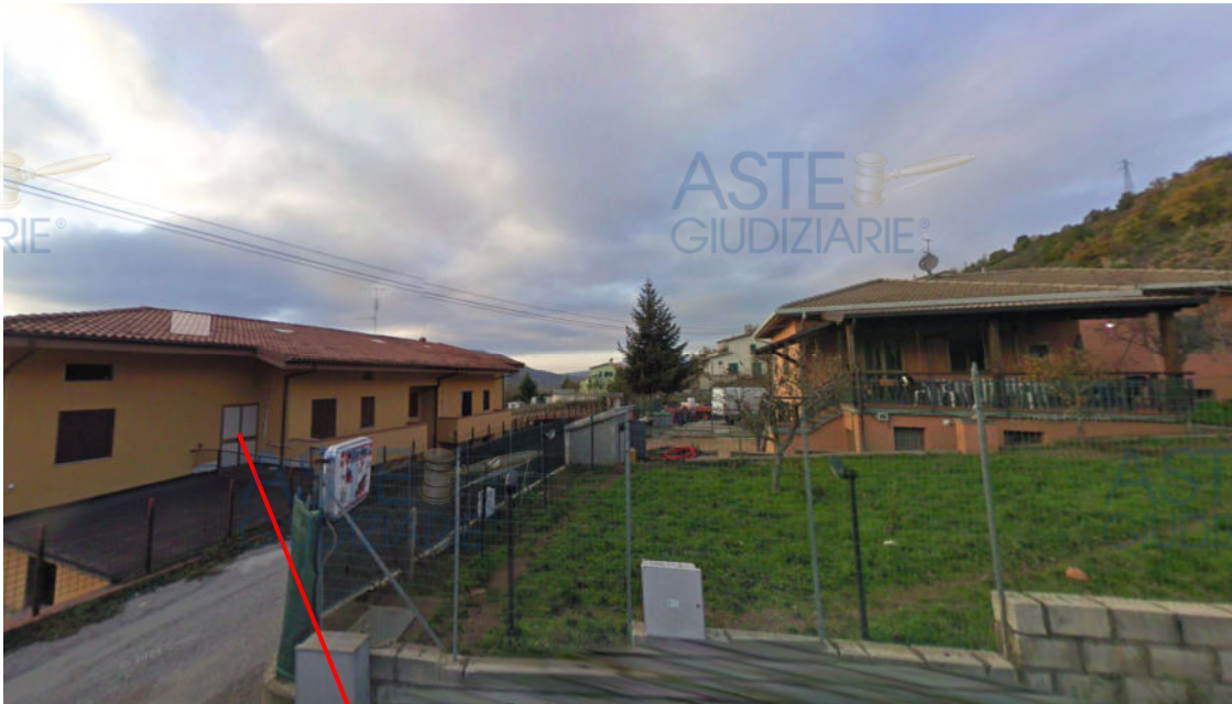
Uscita di sicurezza antincendio collegata alla passerella
