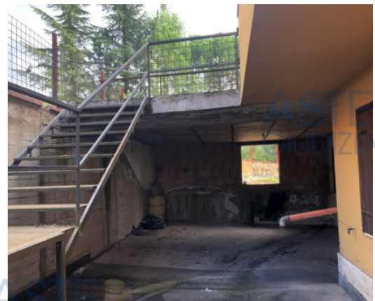
Solaio a fianco alla passerella
