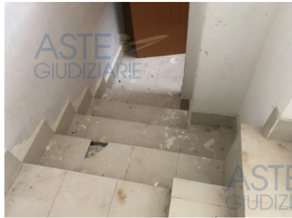
Gradinata di collegamento alla soffitta
