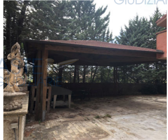
Tettoia B nei pressi dell'ingresso
