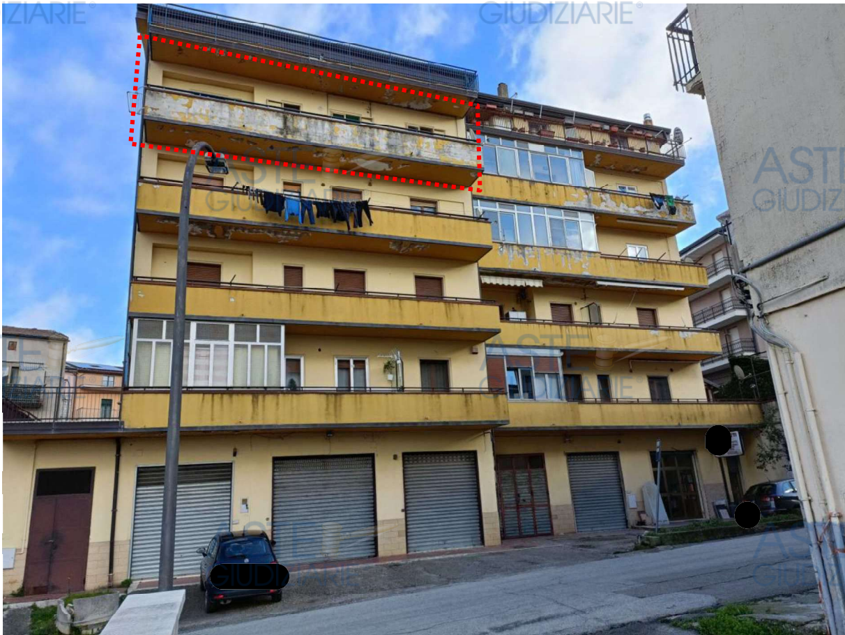
Figura 1 – Panoramica Fabbricato, Foglio 22, Particella 267, Sub 20, Cancellara (PZ).
