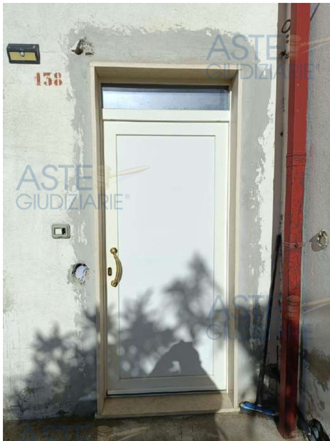
Figura 7 – Portone Ingresso Abitazione Piano Terra.
