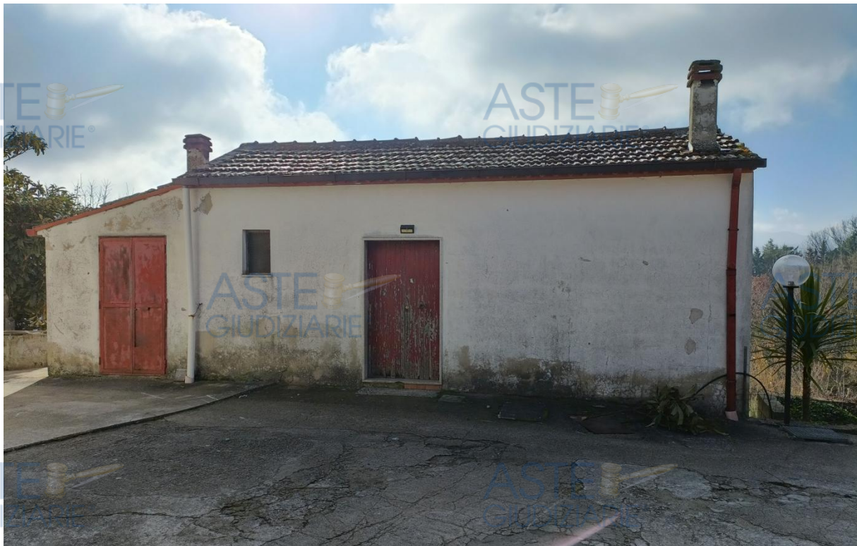
Figura 3 – Panoramica Depositi in Via Donnadezio, n. 149, Potenza (PZ).
