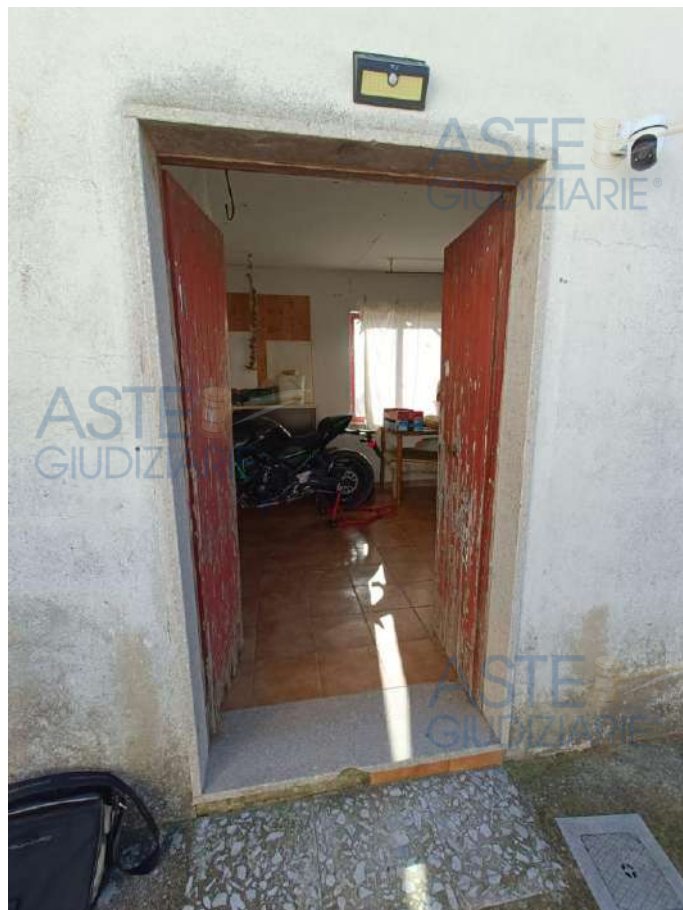
Figura 22 – Particolare Portone Accesso Deposito Piano Terra.
