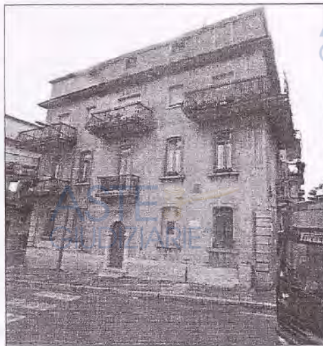
Facciata del fabbricato su Via Generale Pennella
