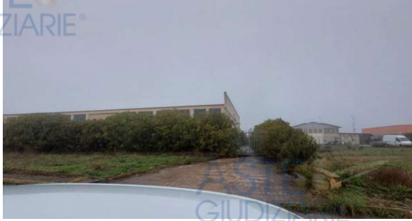
Cancello sud est – vista esterna
