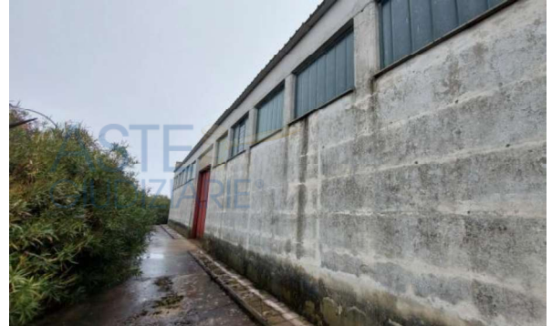
Vista parete nord
