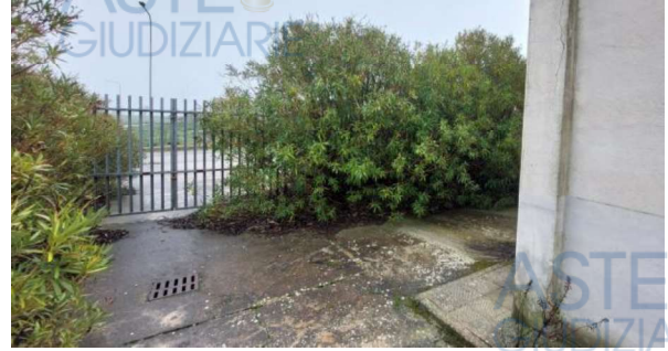
Cancello sud est – vista interna
