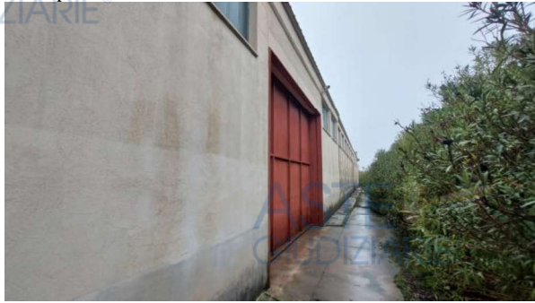
Vista parete sud
