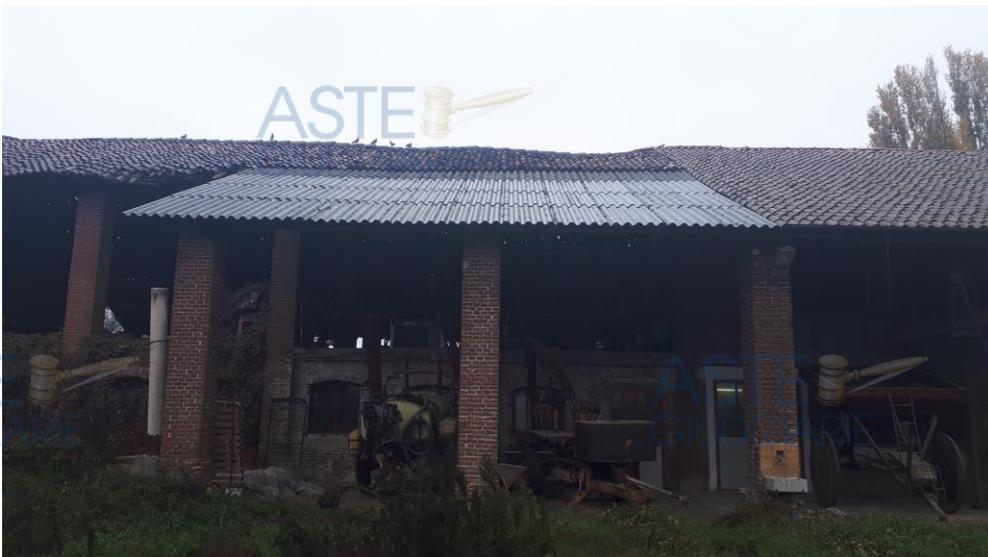
Fabbricato su due livelli oltre a porticato su ambo i fronti. Un porzione su due livelli con copertura in ordine al piano terra depositi e lavorazione riso e al P1 ex ufficio e silos. Altra porzione con magazzino al pt e cassero aperto al P1, copertura da sostituire con parziale bonifica di lastre in eternit.
