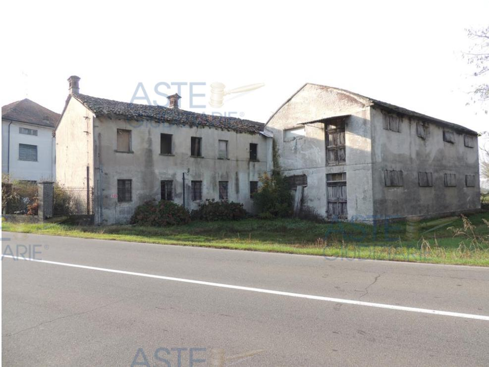
Edificio a produttivo composto da più corpi di fabbrica in aderenza e portico fronte corte interna. Porzione di fabbrica su due livelli ex abitazione per questioni di sicurezza non è stato visionato l'interno, si riscontrano fessurazioni strutturali sulle murature portanti, edificio in pessimo stato. Altro corpo di fabbrica a magazzino, su due livelli con copertura a volta. Portico ed essiccatoio.
