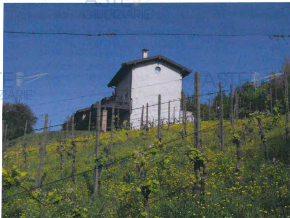
particolare vista esterna fronte strada
