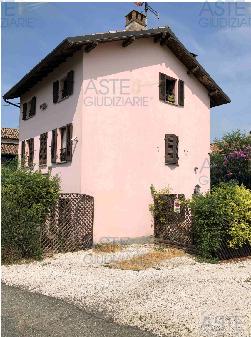
Vista esterno fronte strada e laterale (Sud/Est)
