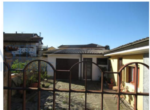
RIPRESA DALLA VIA C. BATTISTI AUTORIMESSA
