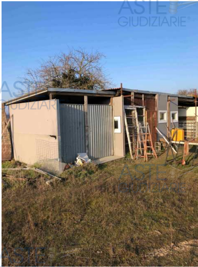
Vista porzione di stallini esterni
