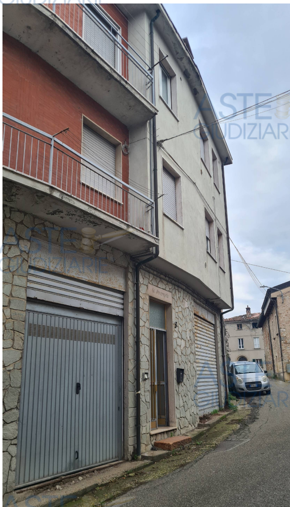
PROSPETTO PRINCIPALE DEL FABBRICATO DI CUI FANNO PARTE DUE APPARTAMENTI E TRE AUORIMESSE
