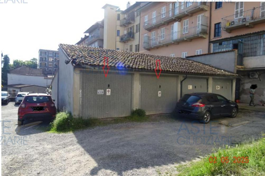
La costruzione presenta un discreto stato di conservazione, e buone caratteristiche costruttive, pareti in muratura e blocchi di cemento, intonaco al civile, solaio inclinato di copertura in latero-cemento.
