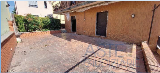
Terrazzo sopra autorimessa
