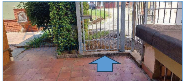
accesso esterno dal sedime di proprietà
