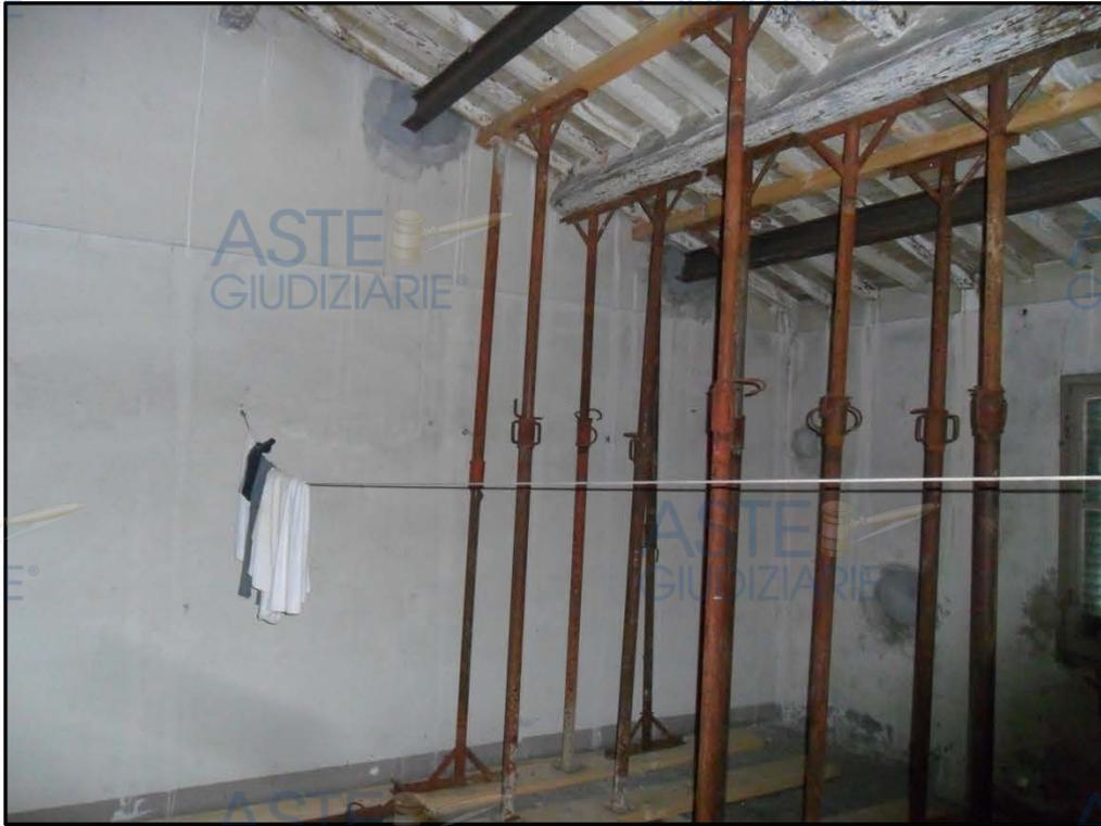
Foto n. 1 - PUNTELLAMENTO SOLAIO DI COPERTURA
