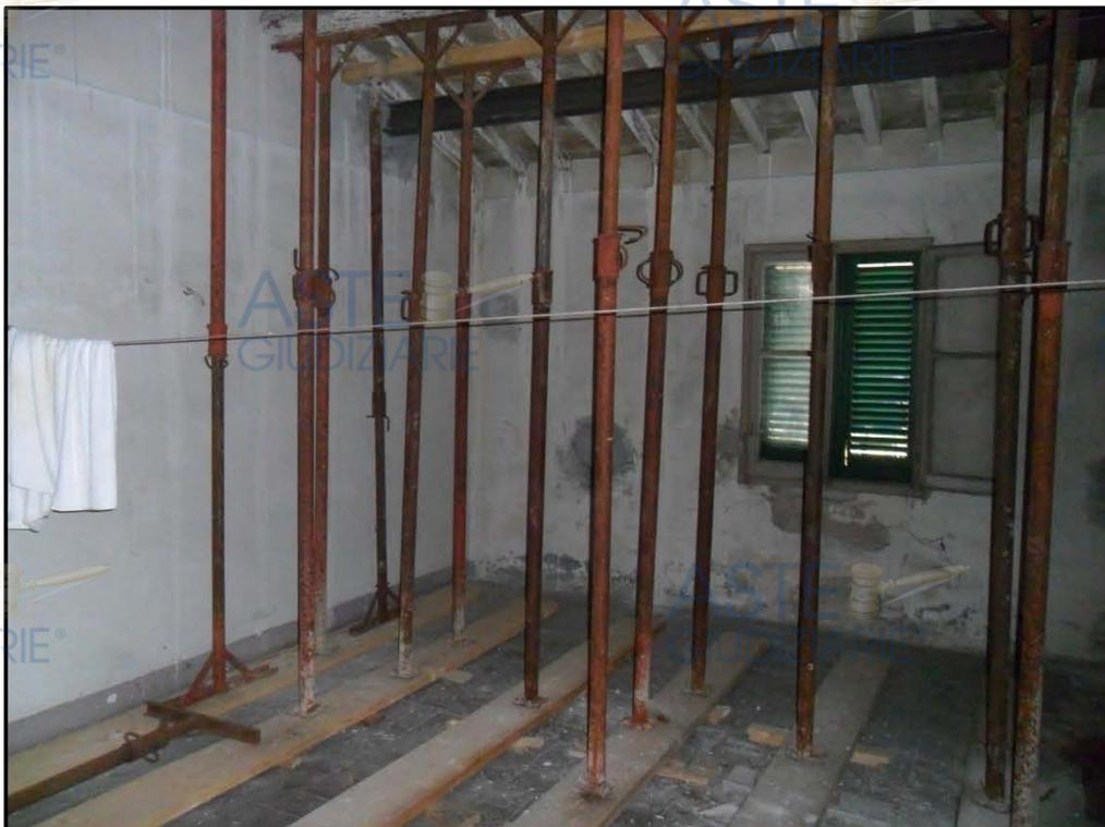
Foto n. 2 - PUNTELLAMENTO SOLAIO DI COPERTURA
