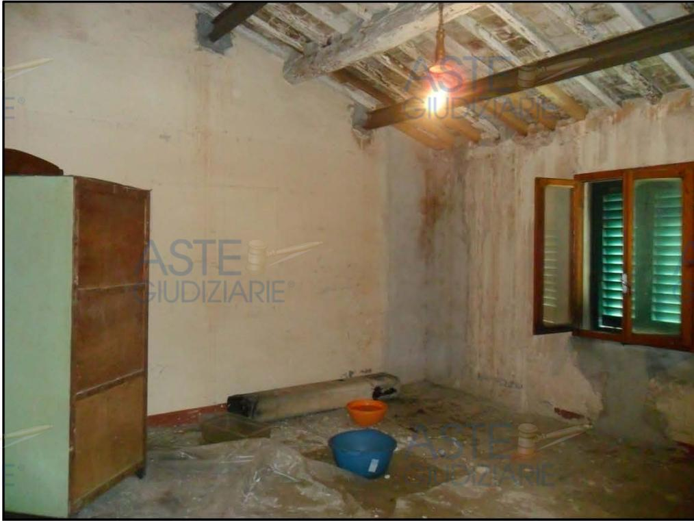
Foto n. 3 – SOLAIO DI COPERTURA RINFORZATO CON FILTRAZIONI D'ACQUA
