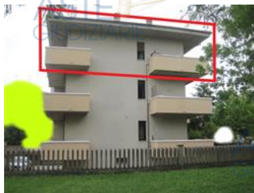
Prospetto laterale fabbricato con localizzazione dell'unità immobiliare oggetto di perizia
