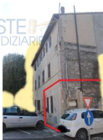
Prospetto laterale fabbricato con localizzazione dell'unità immobiliare oggetto di perizia
