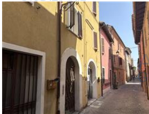
vista fabbricato via de' rusticucci
