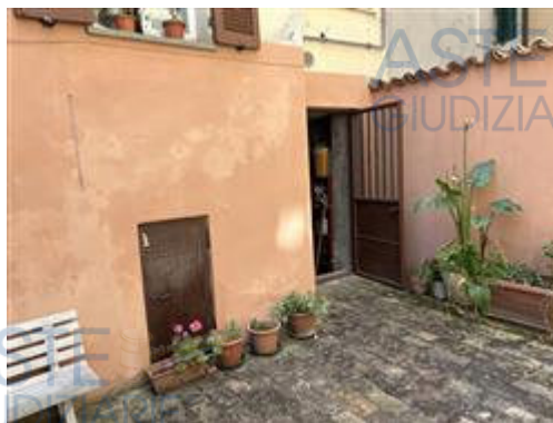
ingresso cantina retro fabbricato
