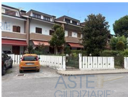
VISTA FRONTALE COMPLESSO RESIDENZIALE
