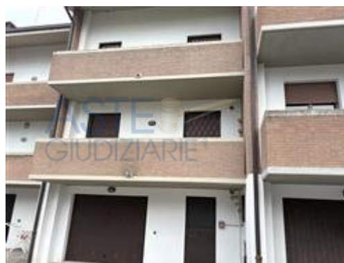
VISTA RETRO-INGRESSO GARAGE -
