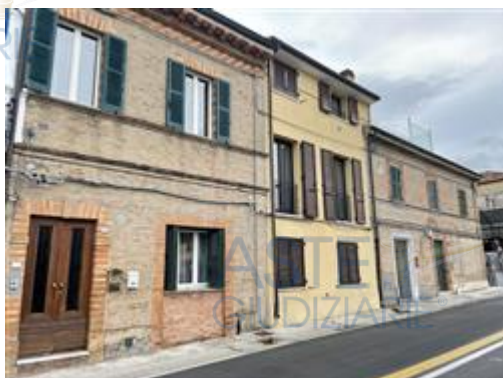
Prospetto lato strada
