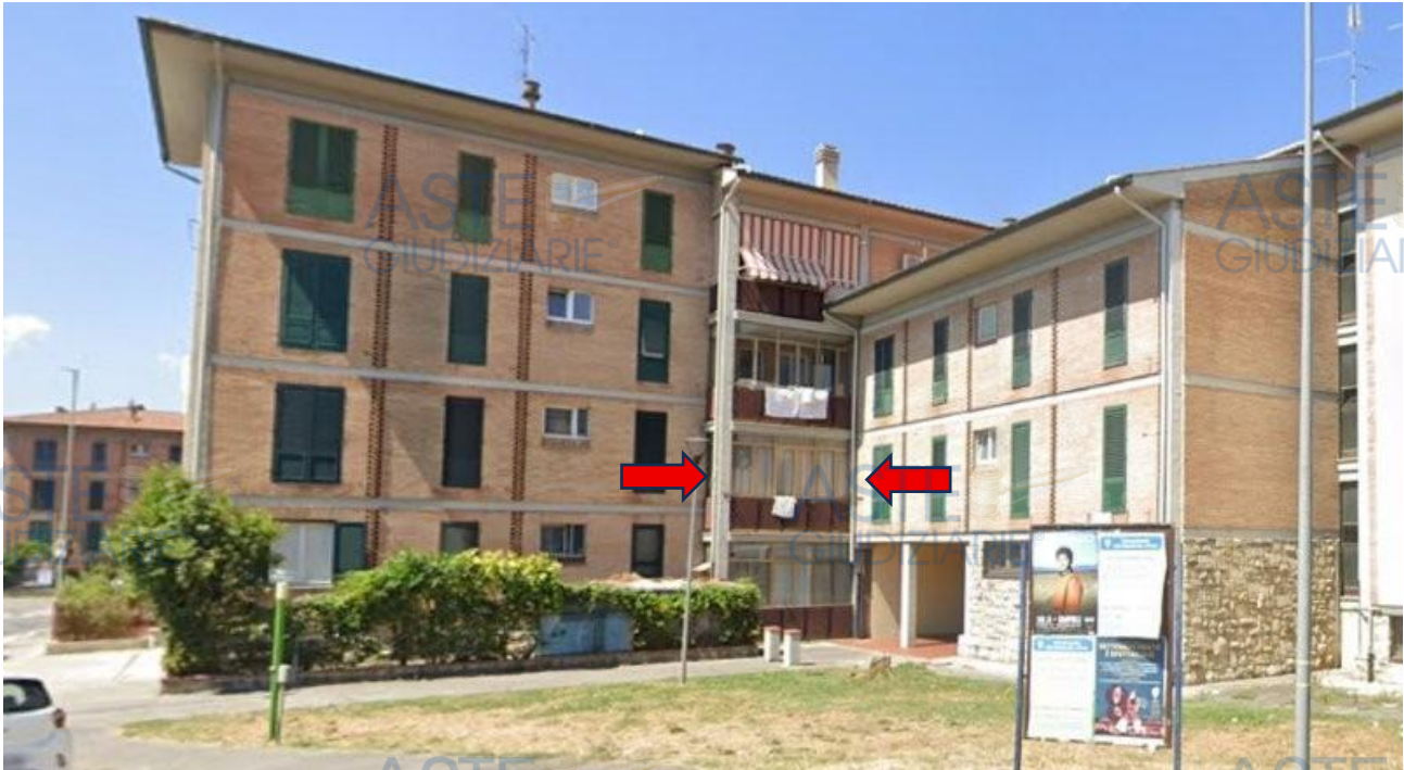
Fig.2 Localizzazione immobile nella torre “70” Corte “L” - veduta veranda da via San Giusto
