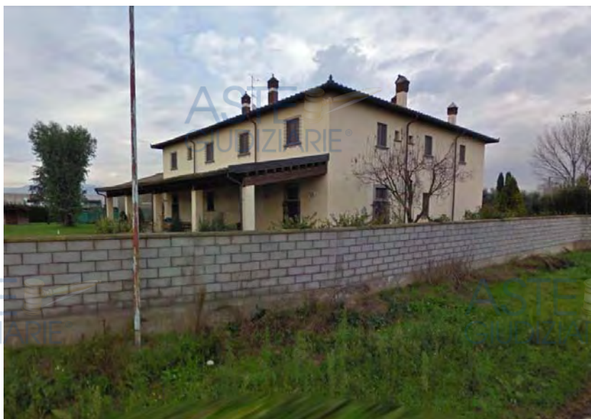
Casa colonica di via Giramonte
