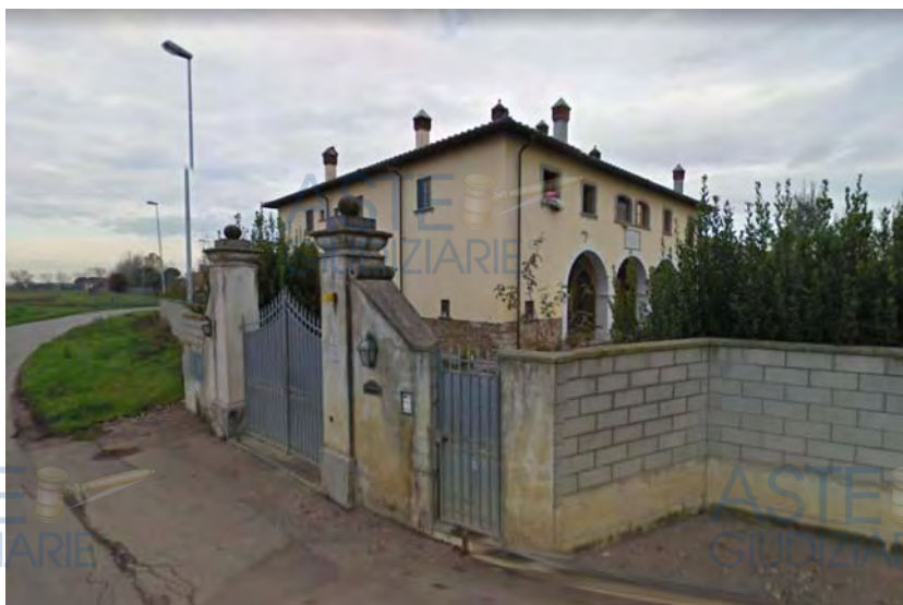
Casa colonica di via Giramonte
