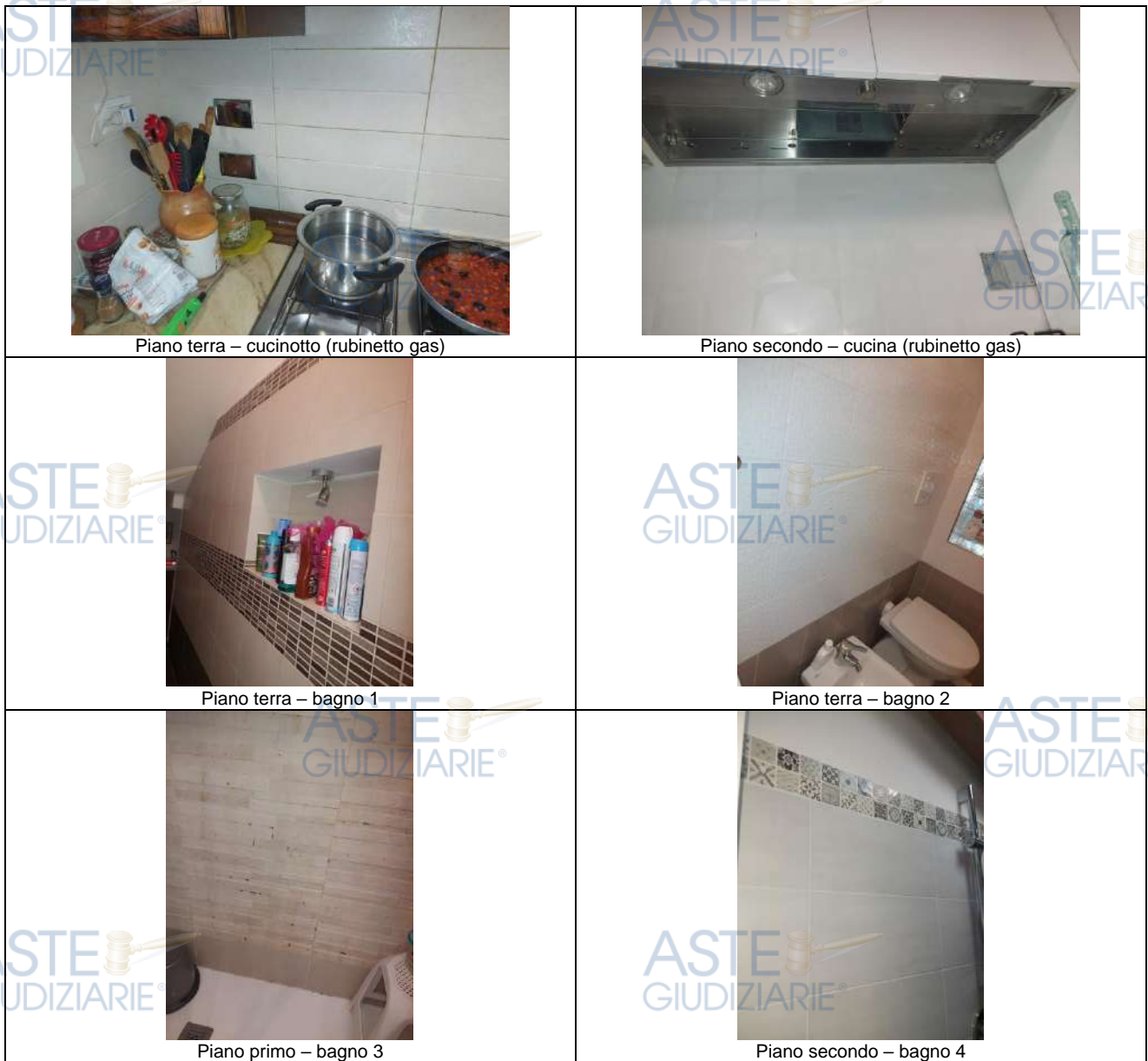
Foto 95: Rivestimenti bagni, cucina e cucinotto
