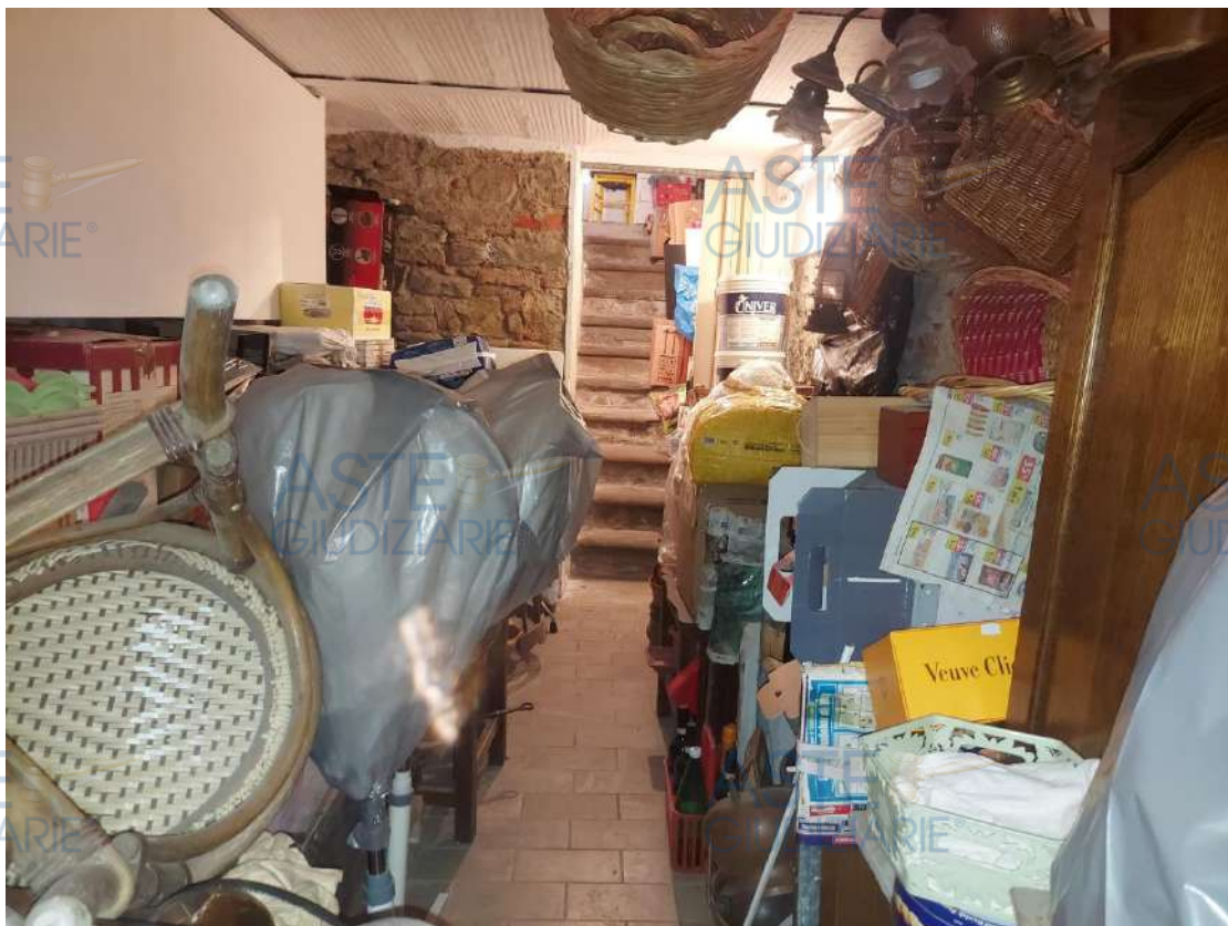
Foto 82: piano interrato - cantina
