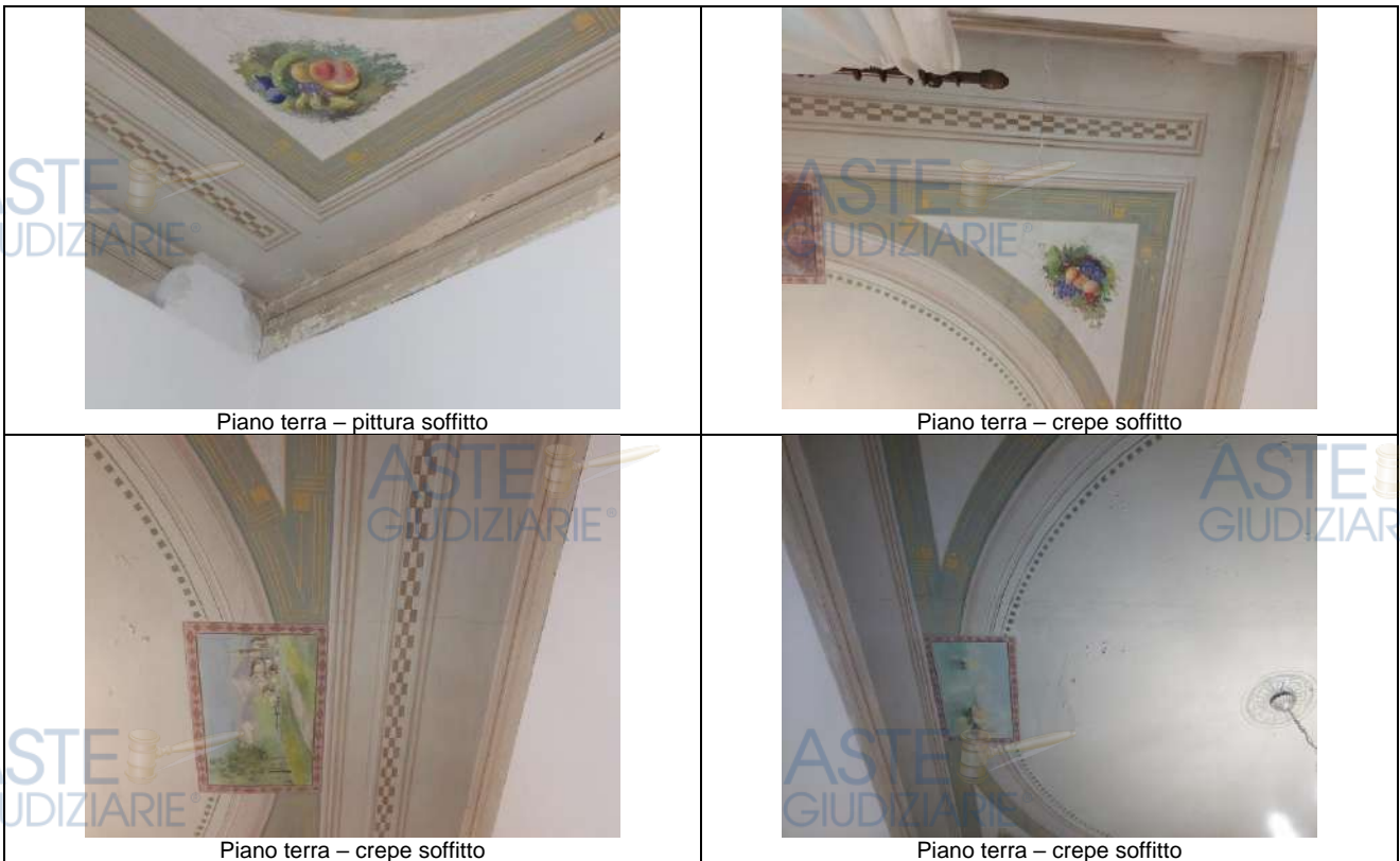
Foto 101: Stato di conservazione
