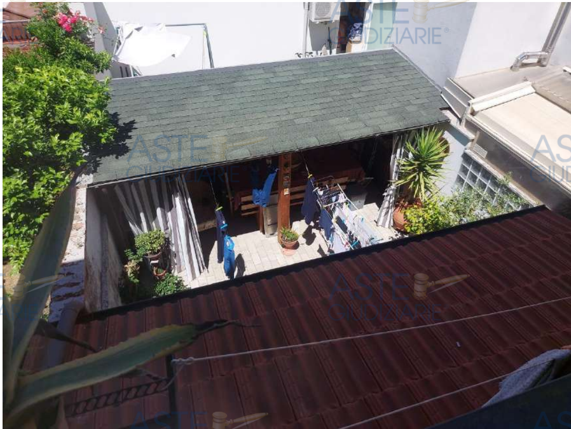
Foto 47: piano primo – balcone 2 – vista su resede tergale
