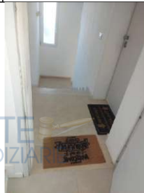
Scala interna – Sub. 503 – sbarco a P1°
