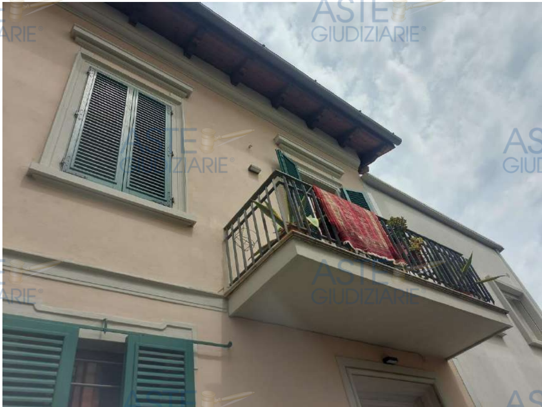
Foto 5: Via Della Robbia – facciata principale – balcone 1
