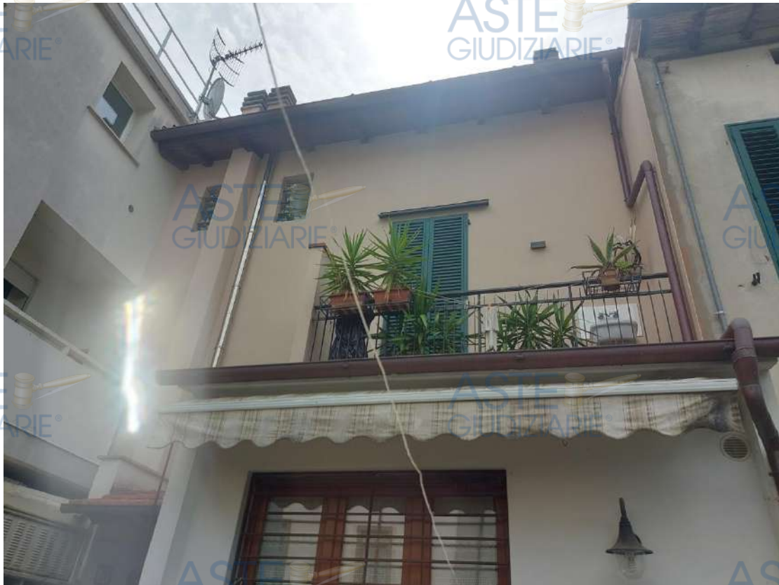
Foto 87: piano terra – resede tergale – balcone 2
