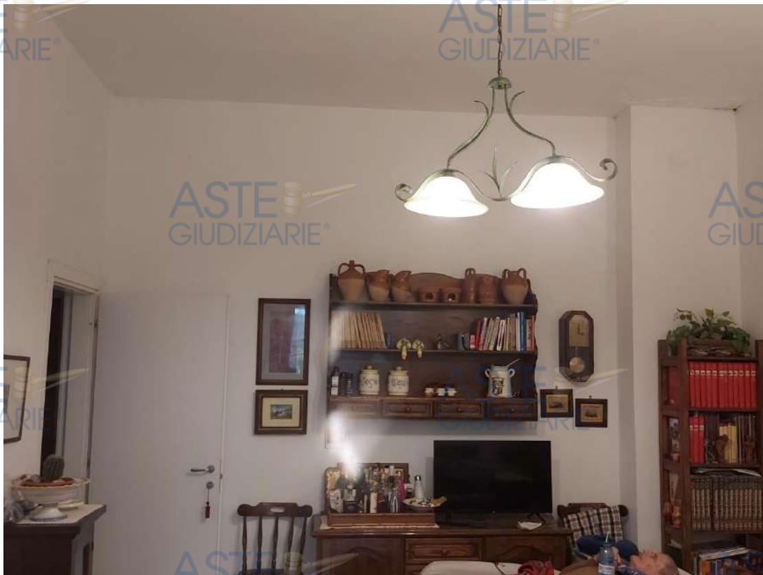
Foto 73: piano terra – sala pranzo 1
