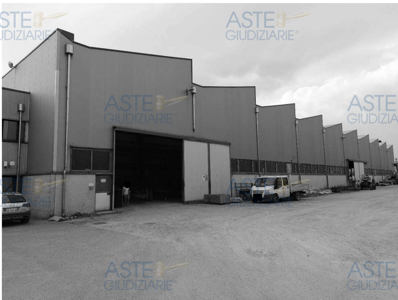
Lotto 1 – Comune di San Vito al Tagliamento (PN), foglio 3, particella n°1478: Veduta del capannone industriale da posizione est.
