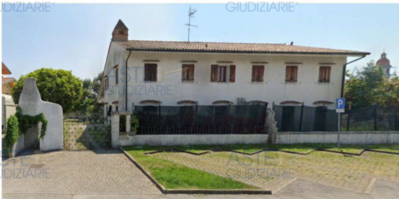
Lotto 2 - Comune di Porcia - Foglio 13 - mappale 700 - Veduta dell'abitazione pignorata da Via C. Colombo.
