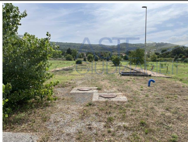
Documentazione fotografica - Vista n.7
