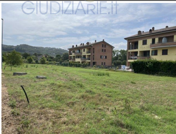
Documentazione fotografica - Vista n.8
