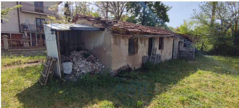
Foto 17 pertinenza esterna - prospetti ovest/nord
