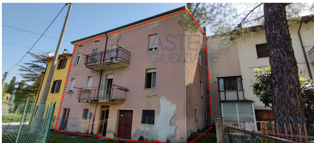
Foto 1 prospetto ovest (ingresso)
