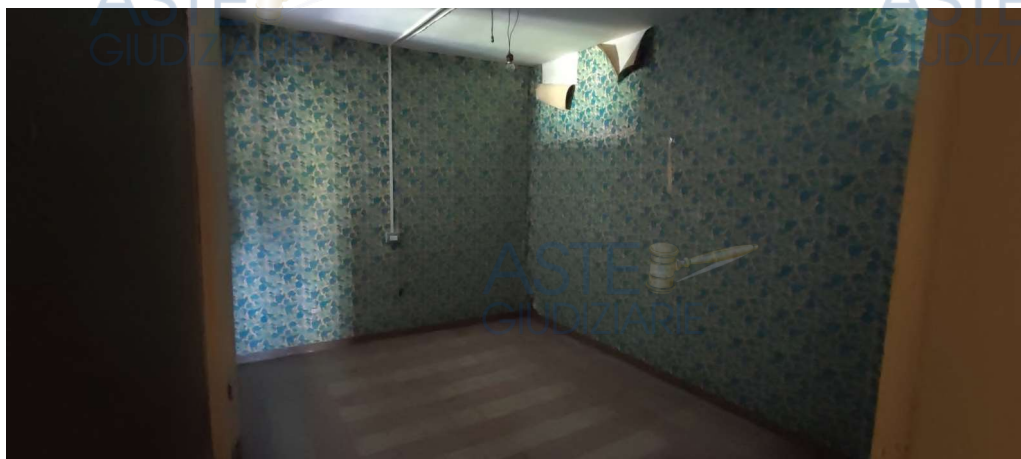
Foto 12 locale di sgombero 2° p.
