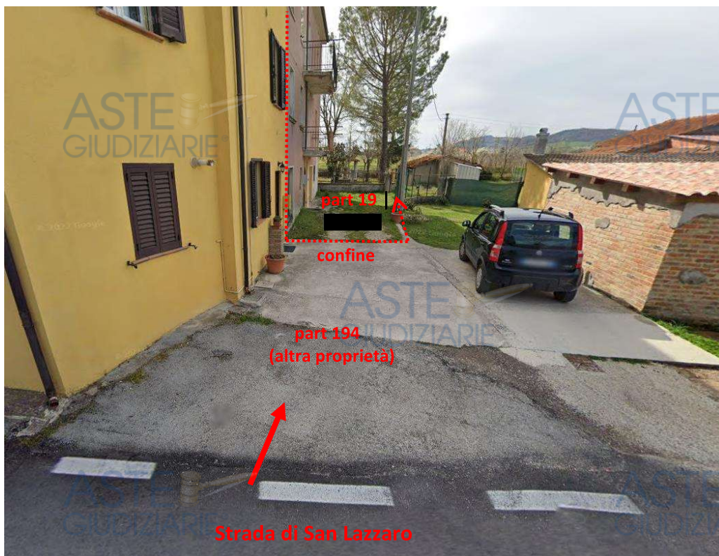
C) FOTO STATO DEI LUOGHI – ACCESSO PROPRIETA' PIGNORATA
