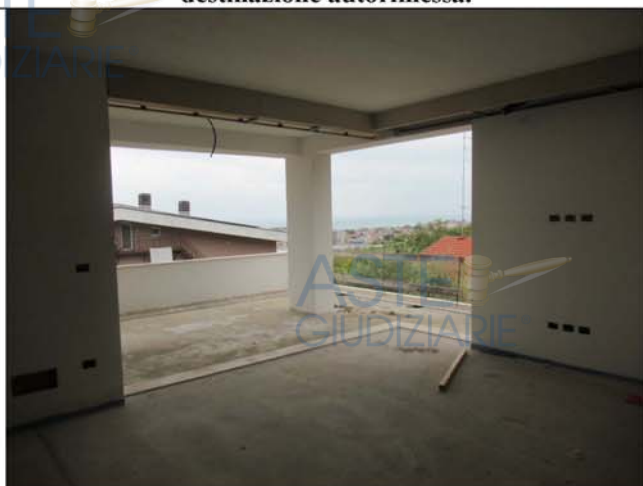
Foto n° 7 - Lotto n. 1 – Piano terra/rialzato, destinato ad abitazione.
