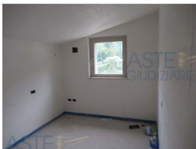
Foto n° 18 – – Lotto n. 2, piano primo, sottotetto.
