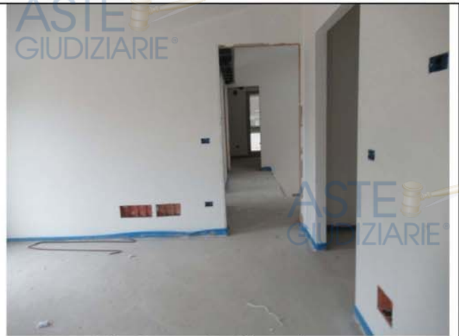
Foto n° 10 - Lotto n. 1 - Piano primo sottotetto, destinato a locali accessori all'abitazione.
