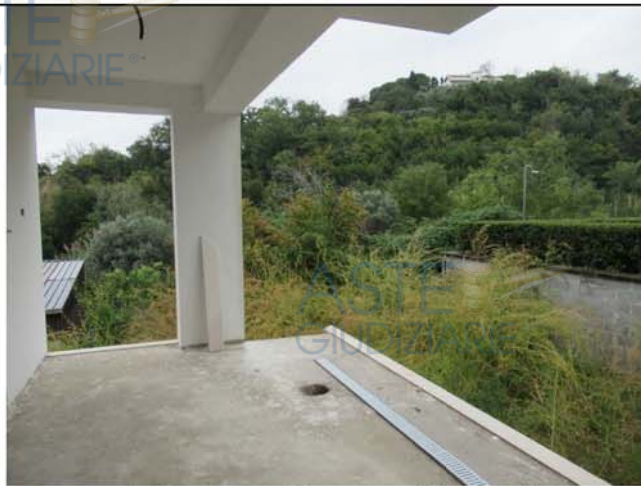
Foto n° 9 - Lotto n. 1 Piano terra/rialzato, balcone retrostante.
