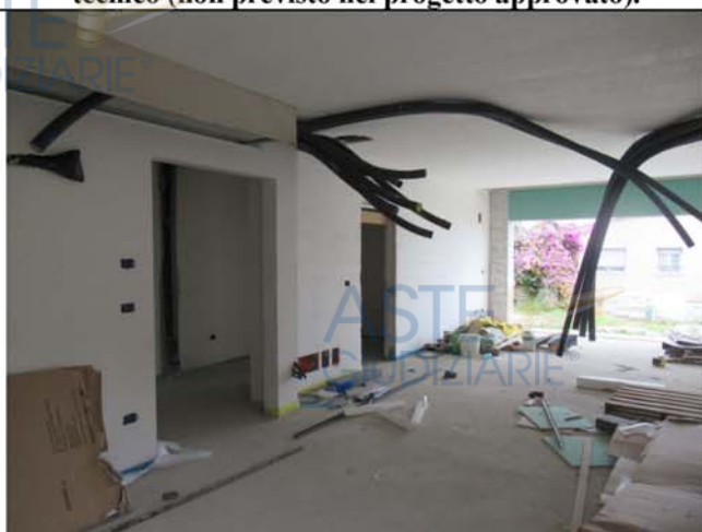
Foto n° 5 - Lotto n. 1 – Interno, piano seminterrato, destinazione autorimessa.
