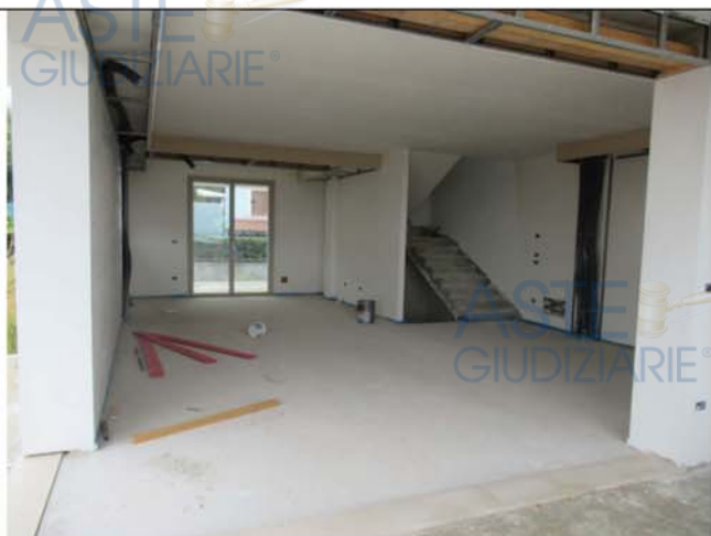
Foto n° 8 - Lotto n. 1– Piano terra/rialzato, destinato ad abitazione.
