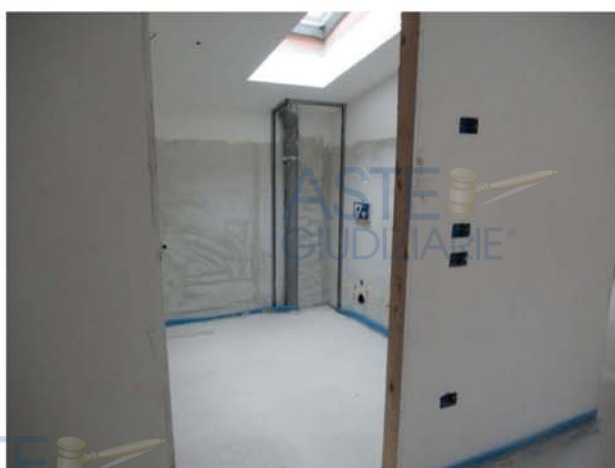
Foto n° 17 - Lotto n. 2, piano primo, sottotetto.
