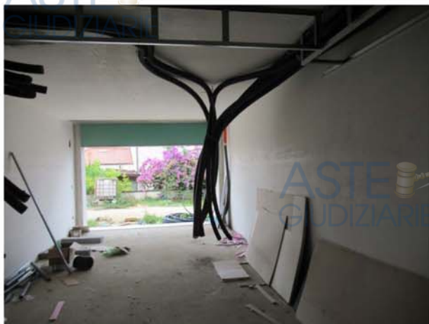
Foto n° 14 – – Lotto n. 2, piano seminterrato, locale autorimessa.
