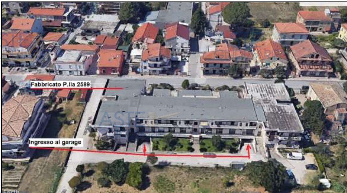
Veduta del fabbricato da Google Earth
