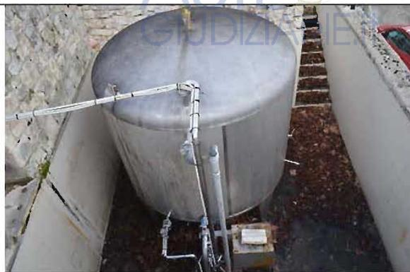
Foto n° 28 - Serbatoio di decantazione acque sulfuree
