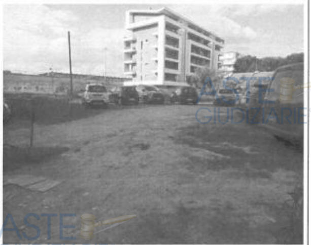
Foto 10 - Veduta terreno da Via Seneca
