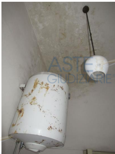
Foto 17 – Volta bagno con infiltrazioni da tetto
