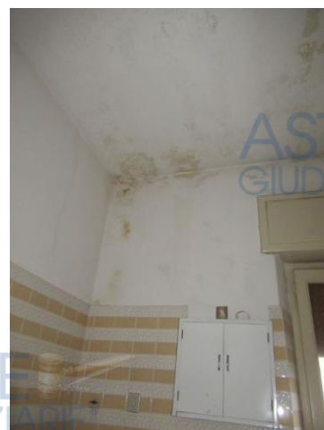
Foto 22 – Appartamento – infiltrazioni dal tetto
