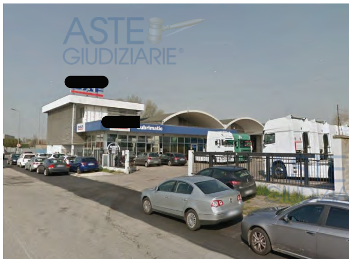
Foto 1 | Vista generale da via Nona Strada
