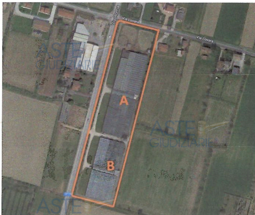
Individuazione del lotto e dei fabbricati | Coord. Google 45°32'53.9"N 11°58'17.3"E
