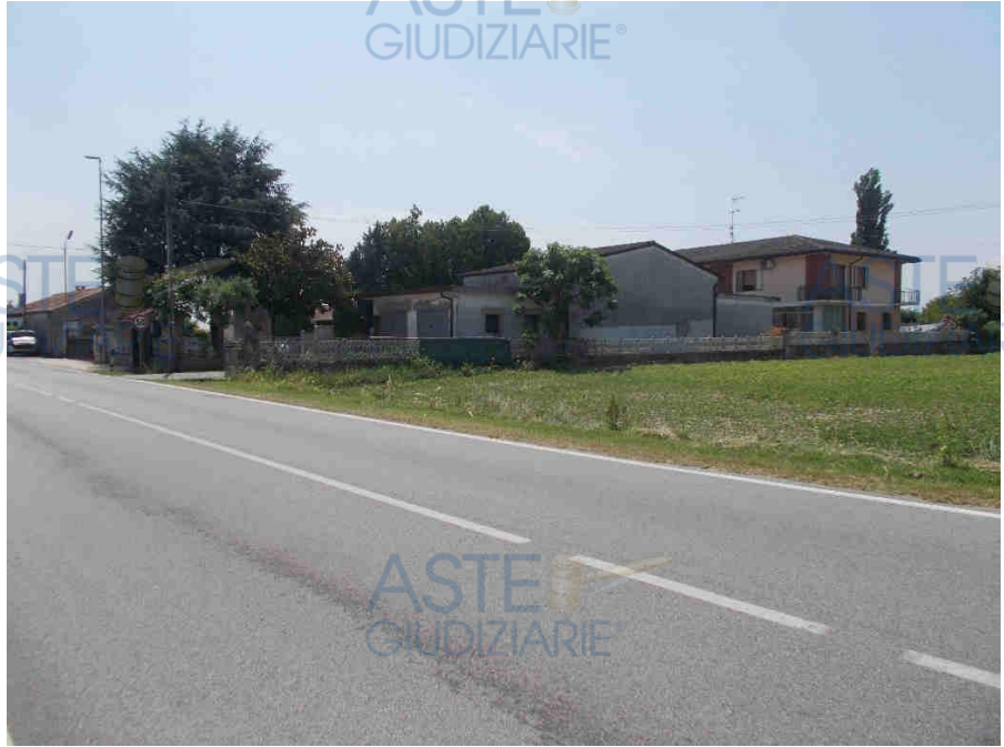
Foto 1- Vista complessiva esterna da nordovest
