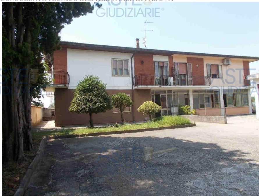
Foto 5- Fronte principale di ingresso al fabbricato residenziale da nord
