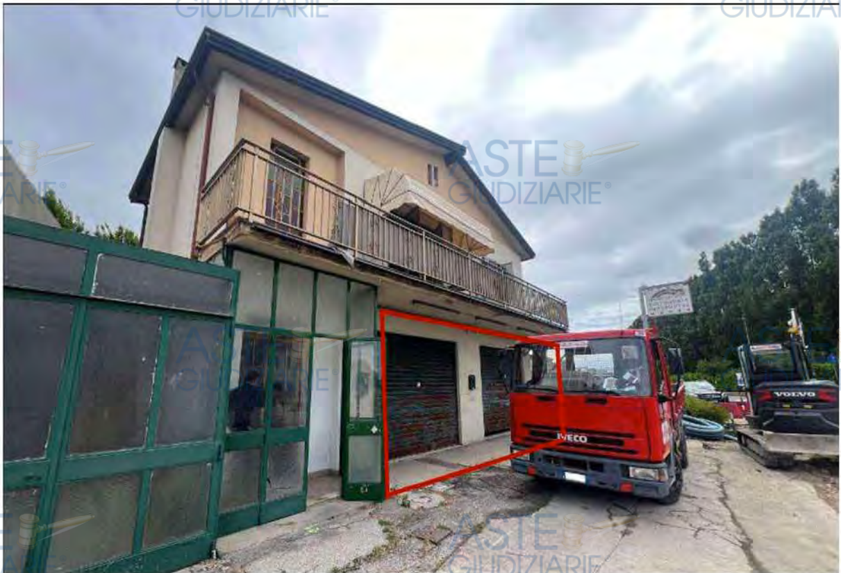
Vista dell'immobile sul quale insiste il negozio oggetto di stima, ripresa dallo spiazzo antistante il fabbricato sul lato Ovest. In rosso è evidenziato l'inquadramento del cespite
