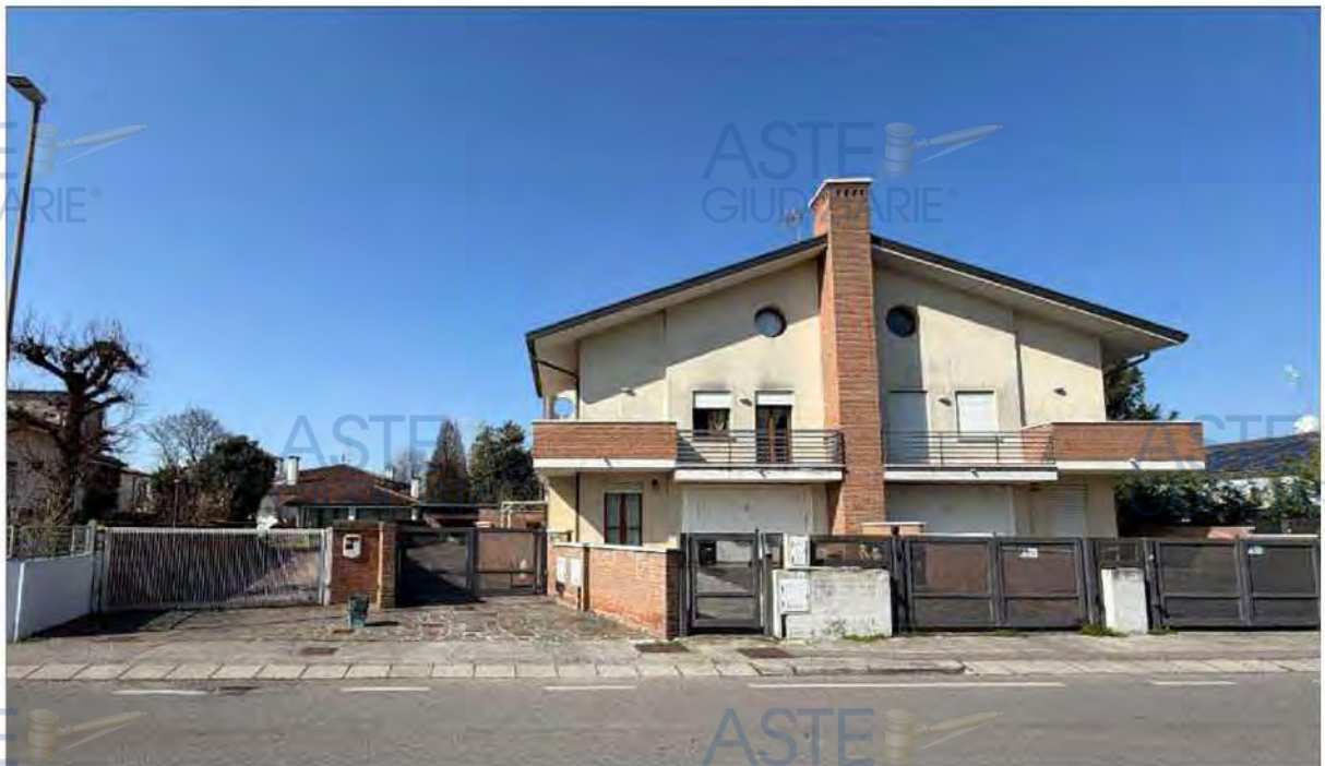
Vista del fabbricato su cui insiste l'immobile in oggetto da via Campello Sopralluogo del 16.03.2026
