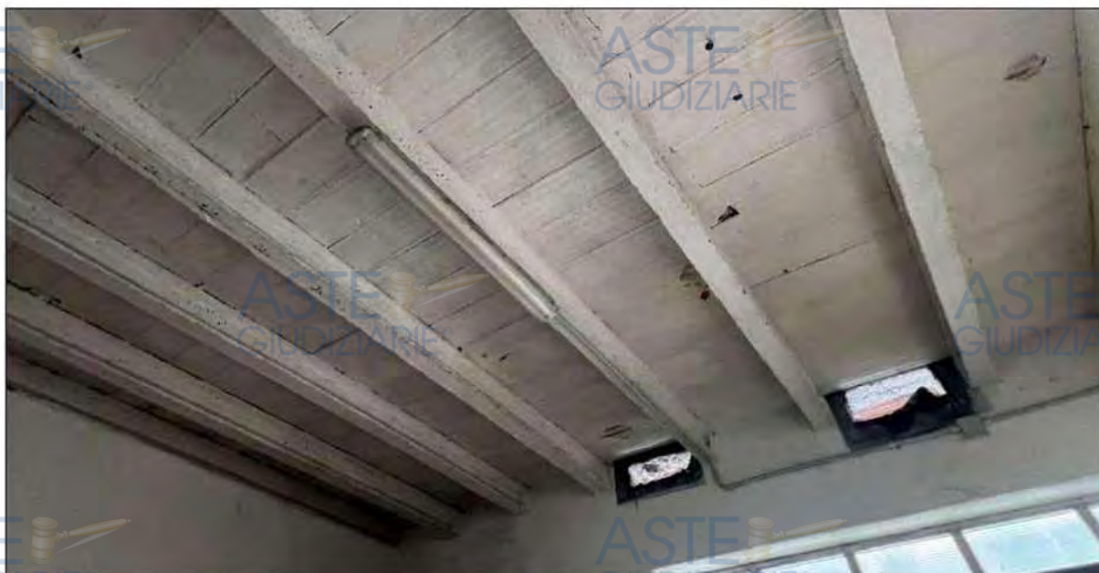
Vista del magazzino sub. 28
