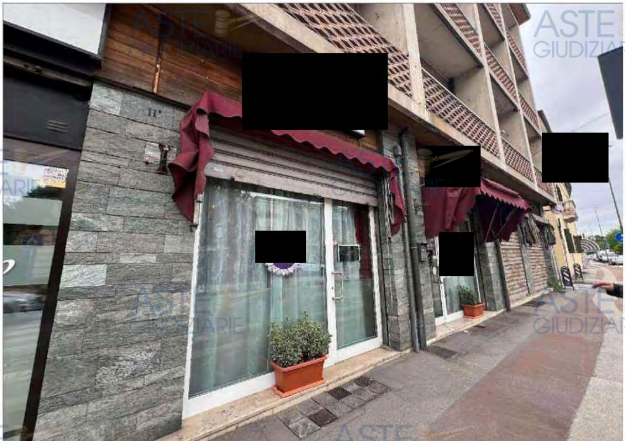
Vista dell'immobile da Sud-Ovest Via San Marco
