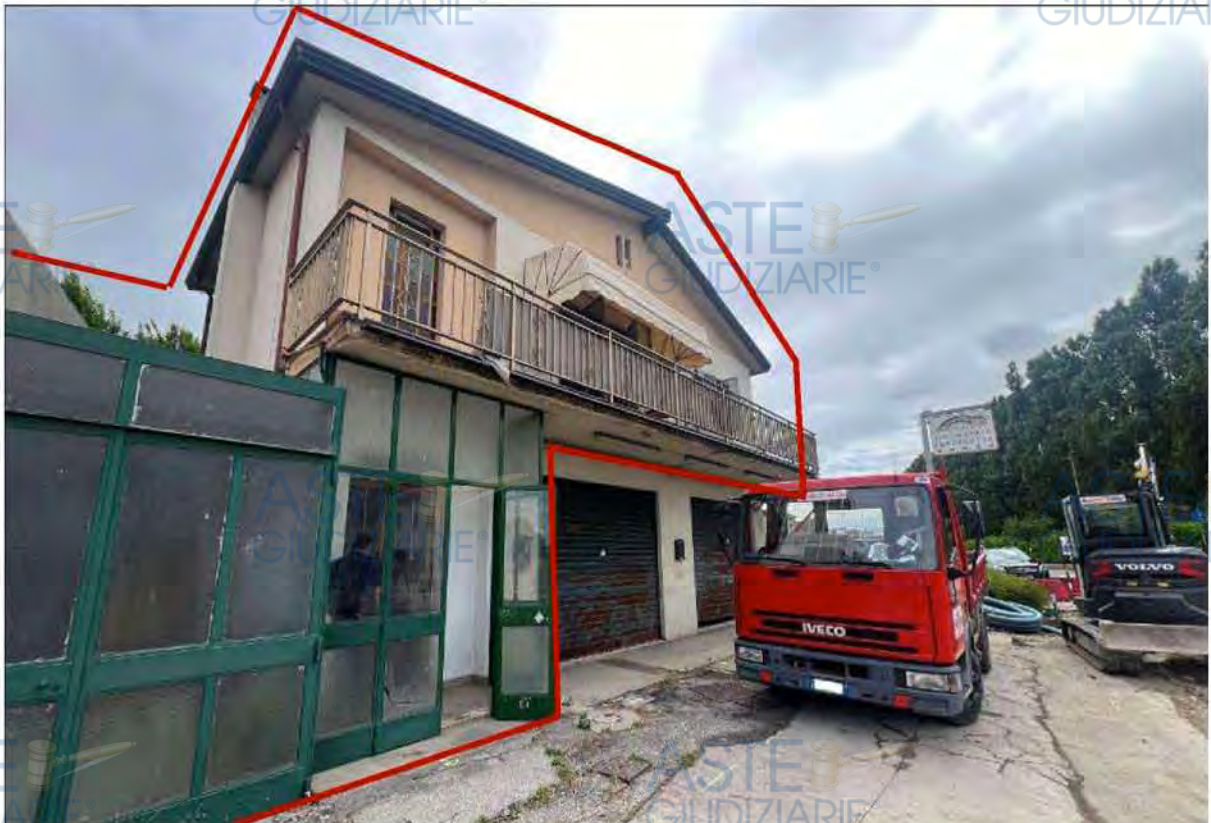
Vista dell'immobile sul quale insiste l'appartamento oggetto di stima, ripresa dallo spiazzo antistante il fabbricato sul lato Ovest. In rosso è evidenziato l'inquadramento del cespite
