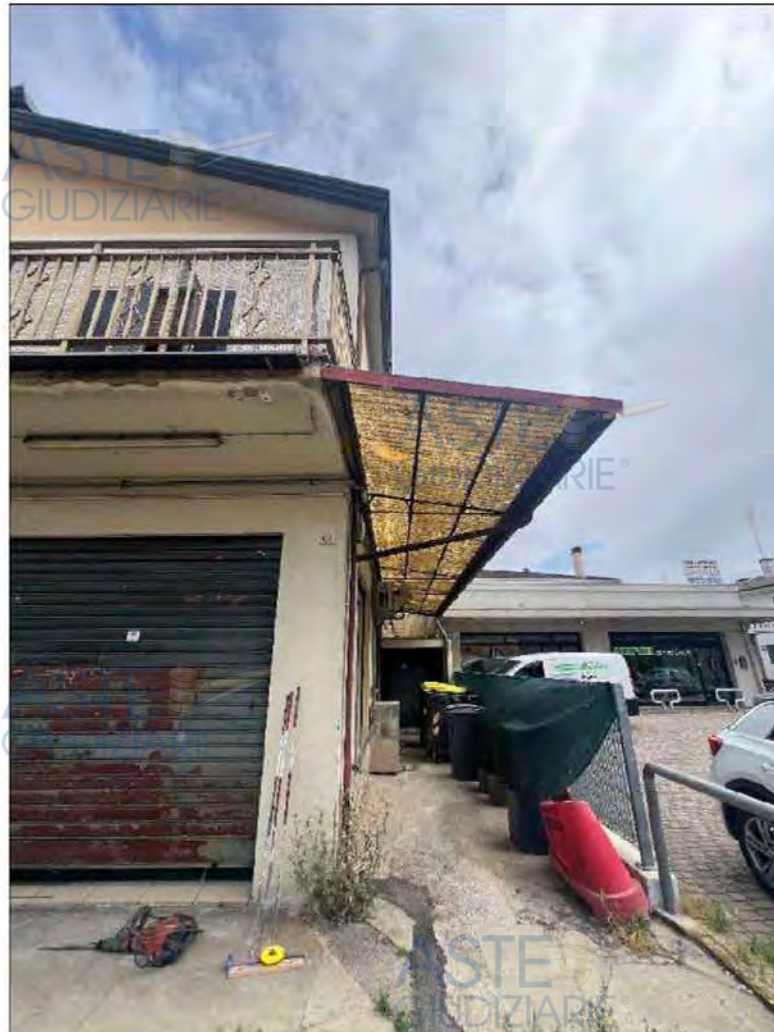
Vista del lato Est
