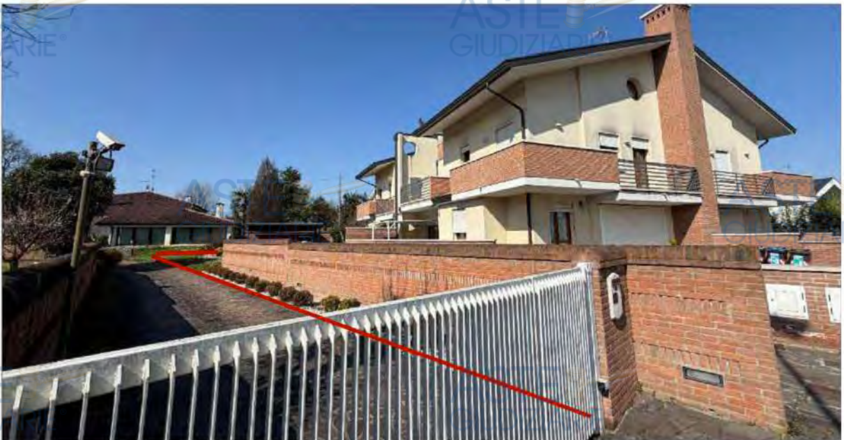
Vista del terreno cui al mapp. 1167 (civico 30) - Sopralluogo del 16.03.2026 studio@architettopavoni.it - info@pec.architettopavoni.it
