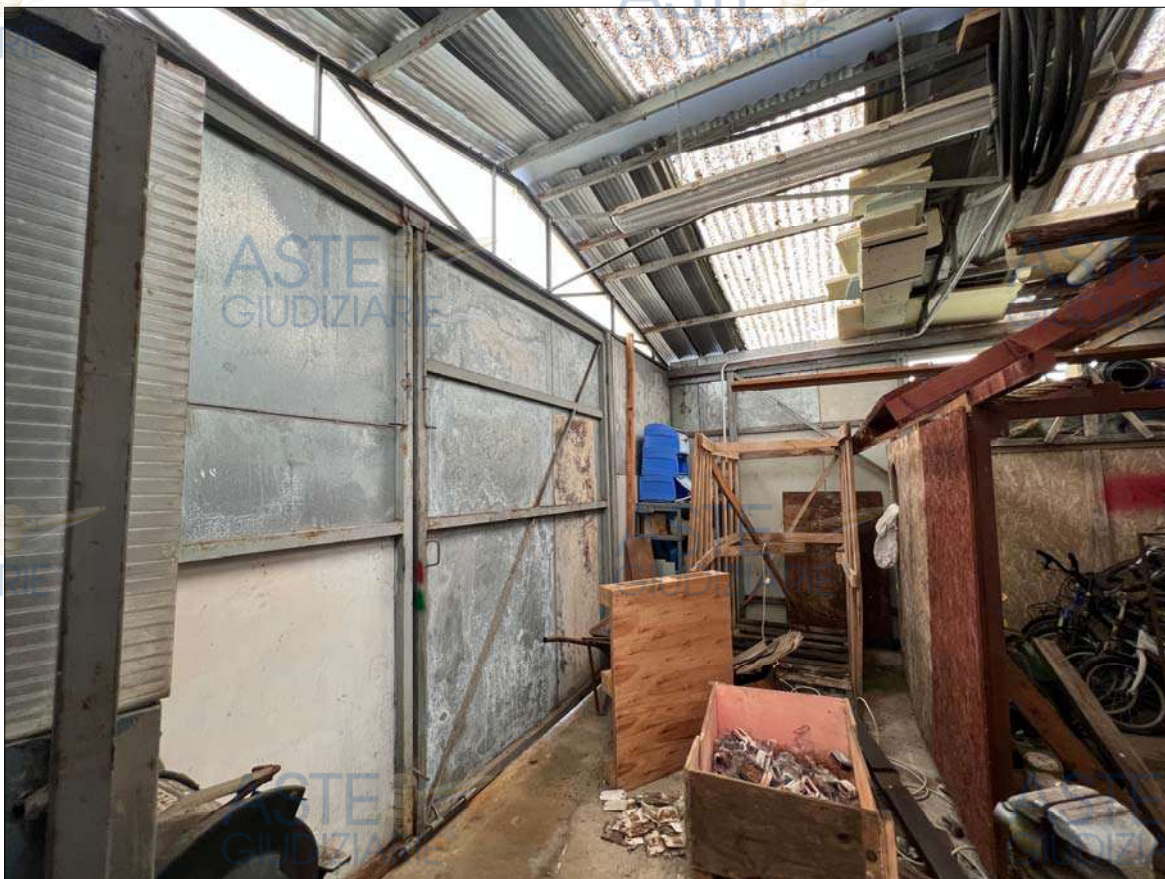
Vista dell'interno del magazzino "H"
