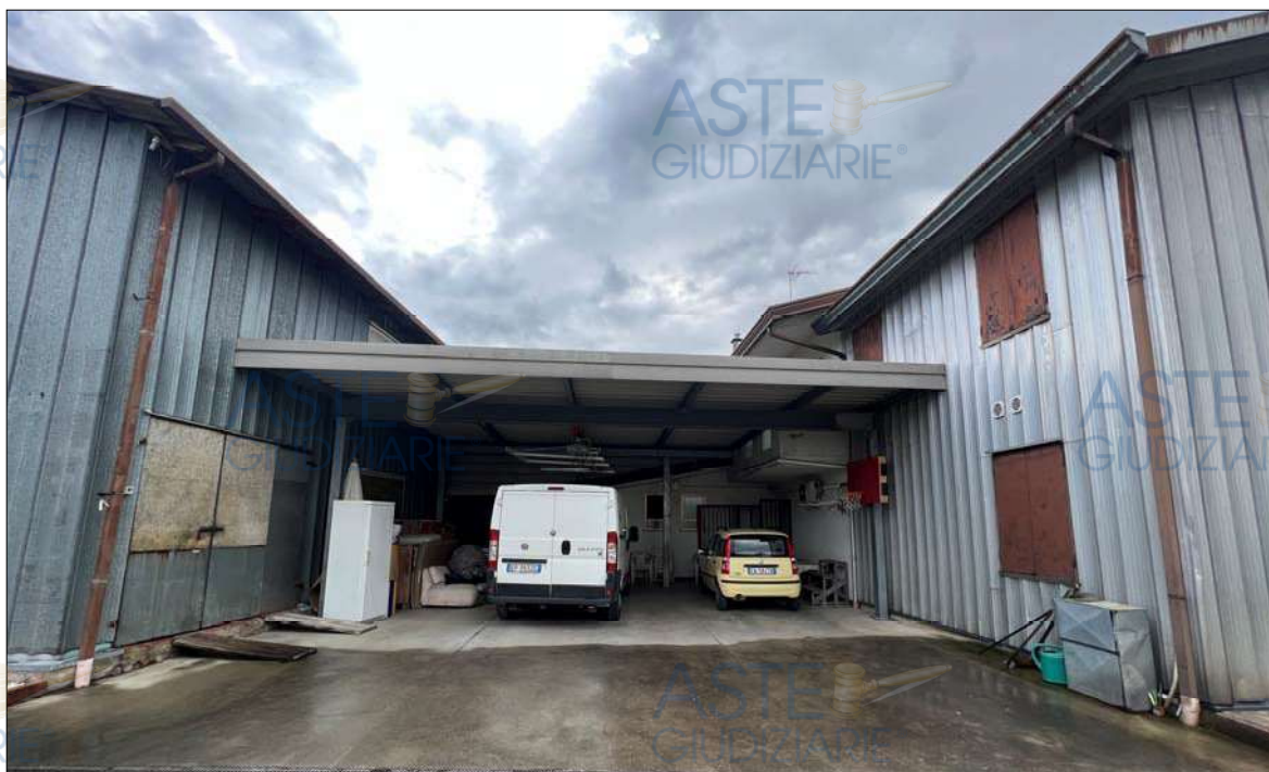
Vista della copertura "D" da Ovest
