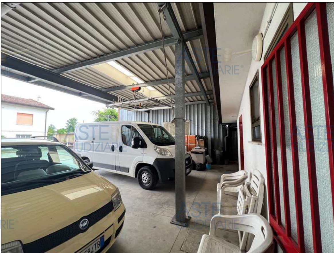
Vista della copertura
