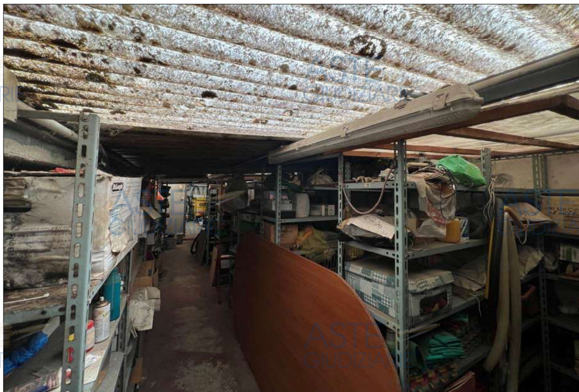
Vista del magazzino "E"
