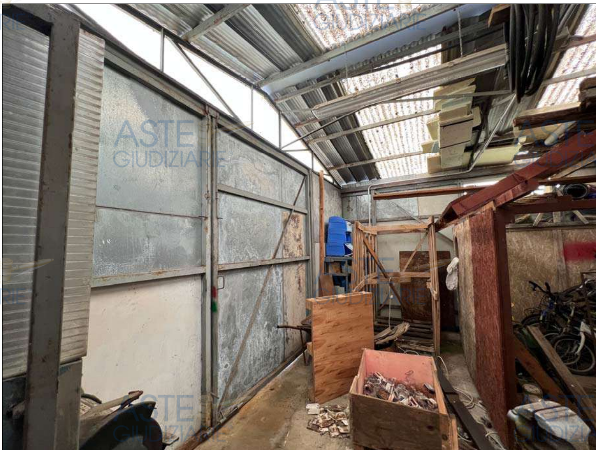
Vista dell'interno del magazzino "H"
