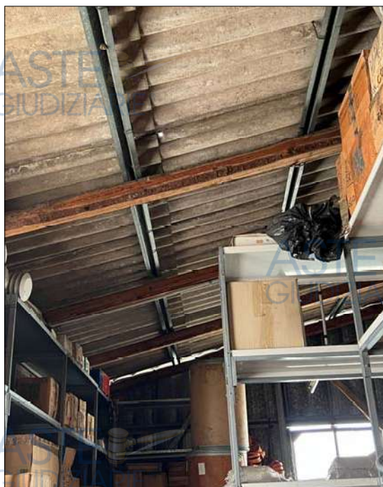
A Dx: Vista della scala e della partizione interna A Sx: vista della copertura in cemento amianto
