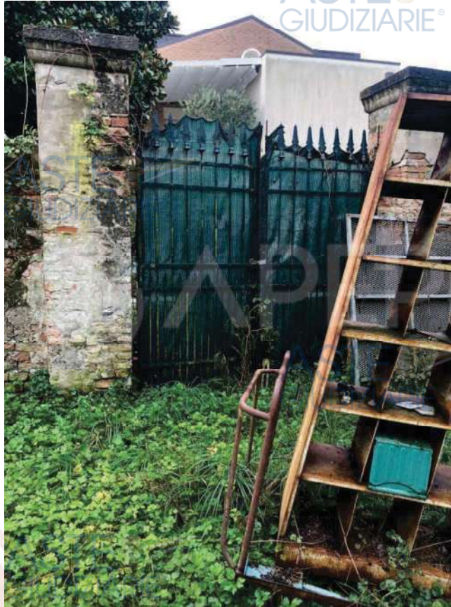
Figura 68 – Cancellato lato sud-ovest
