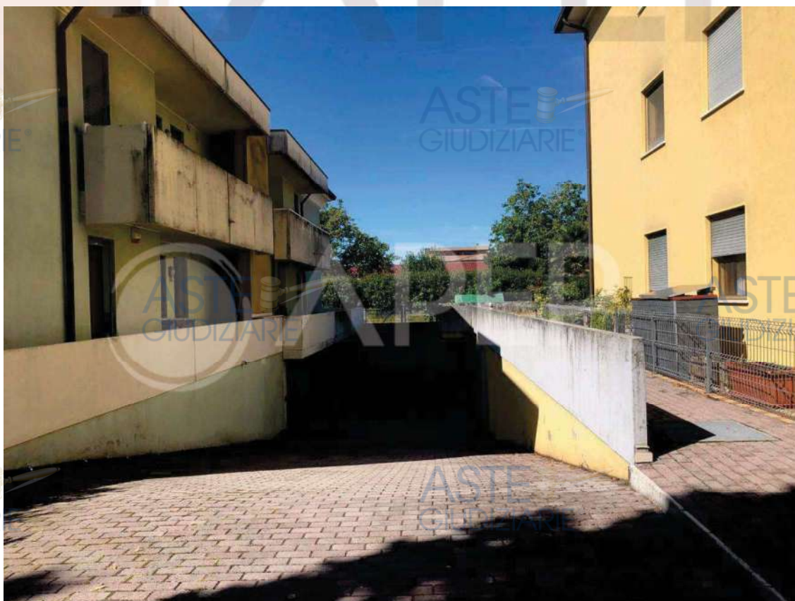
Figura 23 – Rampa di accesso al piano interrato
