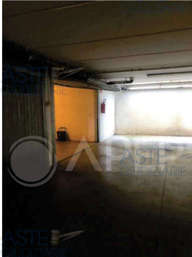
Figura 45 – Area di manovra e garage pignorato
