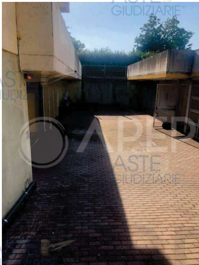
Figura 24 – Spazio di manovra alla base della rampa
