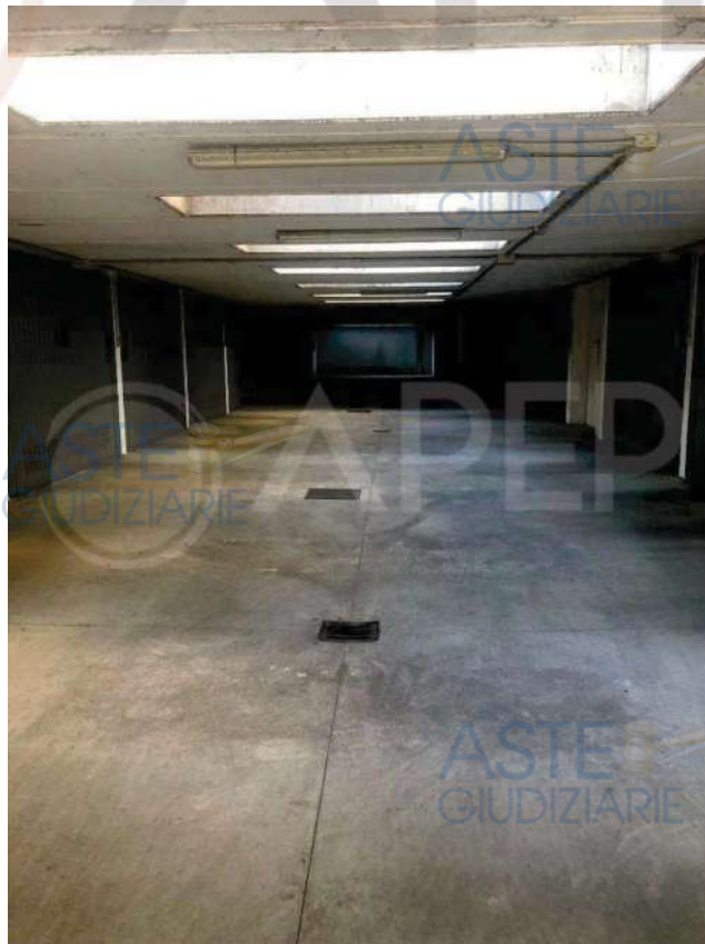
Figura 29 – Corsia di manovra a piano interrato (accesso garage)
