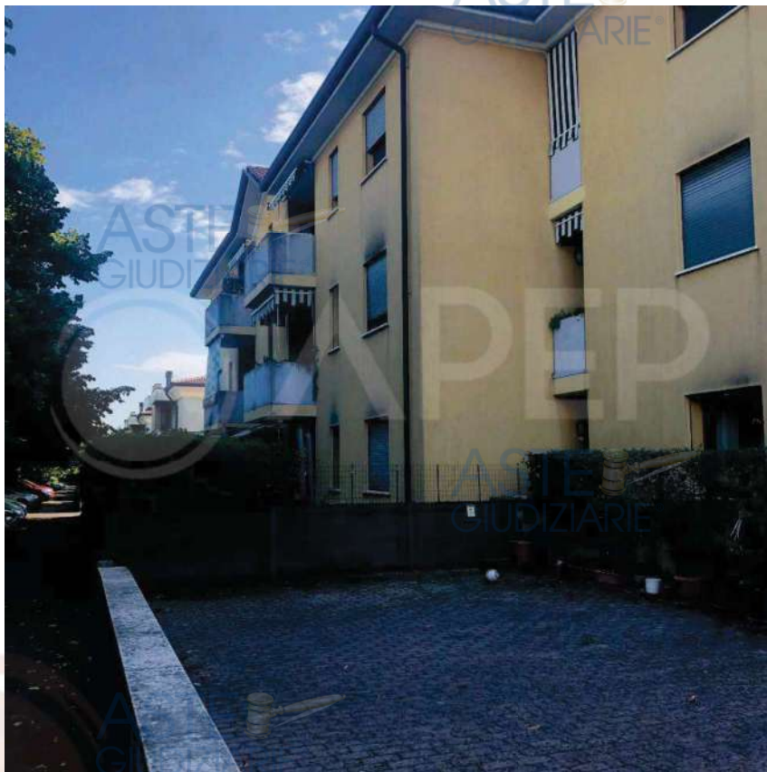
Figura 18 – Facciata su via D'Annunzio
