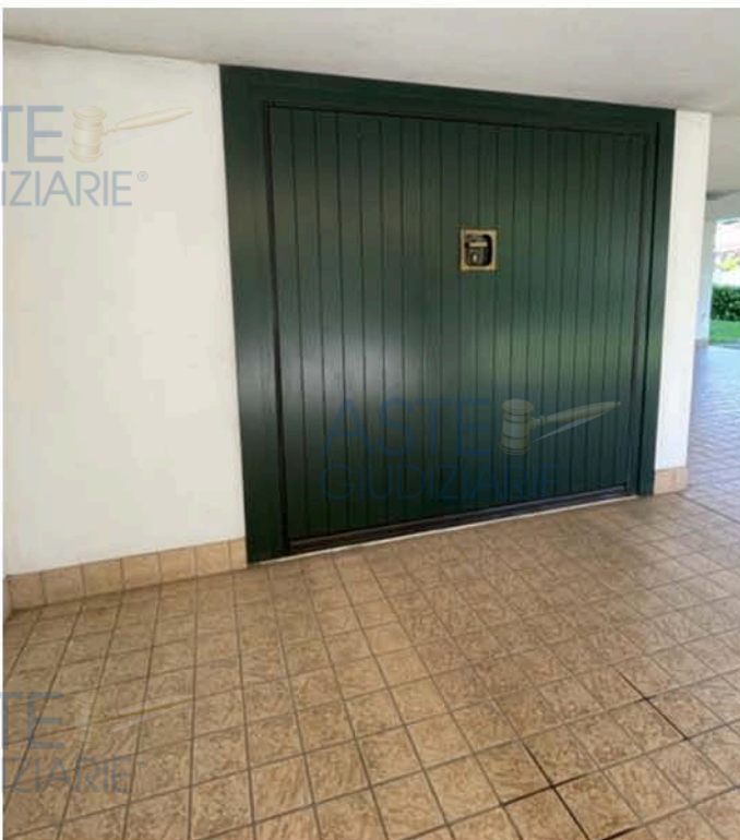
vista del basculante del garage
