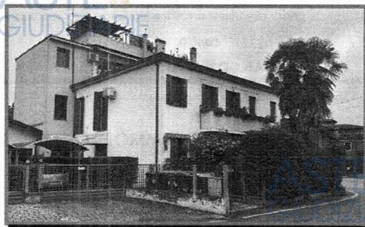
**Strutture:** tipologia tradizionale, in muratura portante di laterizio su fondazioni in c.a., solaio intermedio in latero cemento, copertura con struttura latero-cemento e tetto a falde, facciate intonacate e tinteggiate. Le finiture risalgono all'epoca di costruzione (1996).
