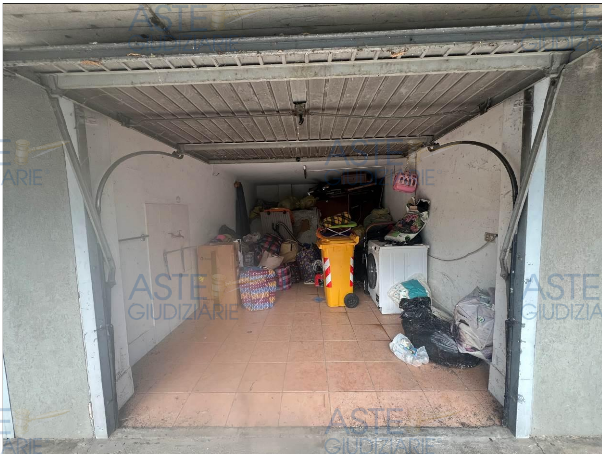
Vista del box auto al piano terra
